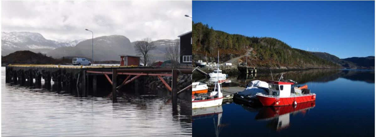
Figur 12: Eksisterende Monstad kai til venstre. Straum kai til høyre, dagens kai ses nedenfor veien i bakgrunnen.
