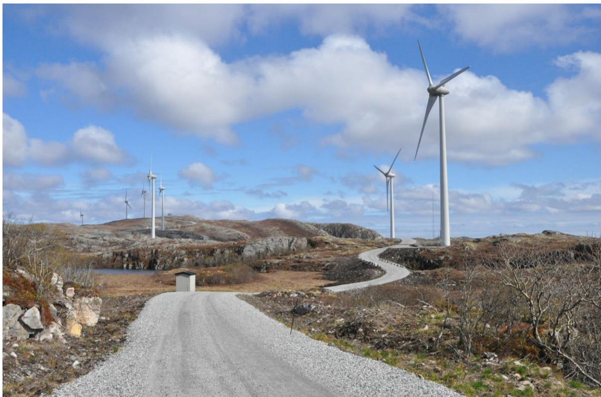
Figur 12. I det småkuperte landskapet er økt veglengde å foretrekke foran skjæringer i tillegg kan traseen med fordel legges med litt høyde i terrenget, da fyllinger i prinsippet lettere kan gis en naturlig tilpassing enn skjæringer.
