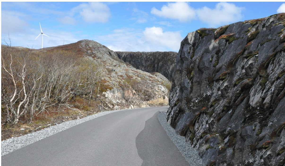
Figur 14. Manipulert bilde viser en tosidig skjæring der det ikke er gjort tiltak for å dempe den visuelle virkningen av skjæringen til høyre i bildet.
