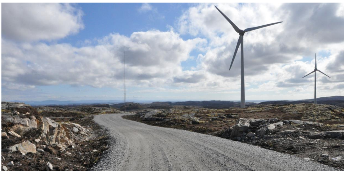
Figur 19. En mindre skjæring står igjen på venstre sida av vegen. Mindre pigging i toppen, som vist på manipulert bilde nederst, er alt som skal til for at oppstikkende nabber på begge sider av vegen skal bli mindre påfallende.
