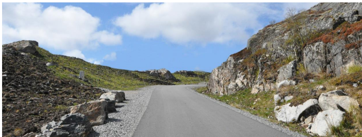
Figur 22. Ved behov for ekstra masser tas positive former ut i sin helhet. I det manipulererte bildet under er en større gjenstående knaus etter innføring av atkomstveg benyttet, samtidig som man har tatt toppen av skjæringa på motsatt side. Mindre knauser har fått stå igjen for variasjon og en mer naturlig flate.
