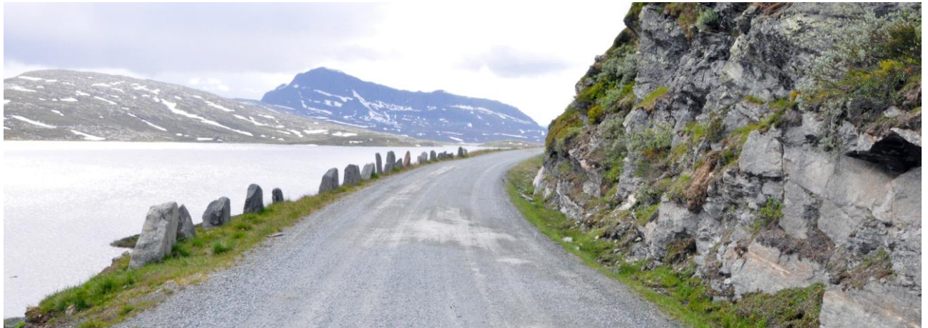
Figur 10. Bildet viser en godt tilpasset stabbesteinssikring ned mot Vinstervatn.
