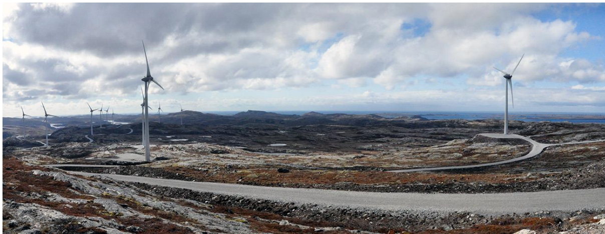
Figur 26. Panoramabildet viser kranoppstillingsplasser som generelt ligger godt i terrenget, med unntak av den ved vindturbinen til høyre i bildet som ligger noe høyt og blir dertil eksponert.
