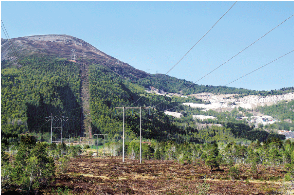
Figur 25. Bildet viser parallellføring av to ledningstraseer, der linja til venstre i bildet har begrensa skogrydding og er langt mindre synlig enn linja til høyre. (Foto: Statnett)
