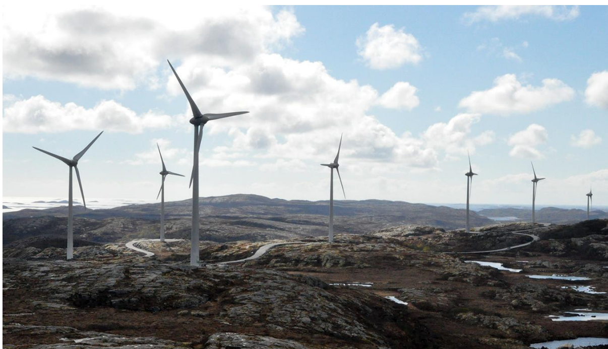
Figur 13. Bildet viser hvordan et godt tilpasset vegnett slynger seg med terrenget.
