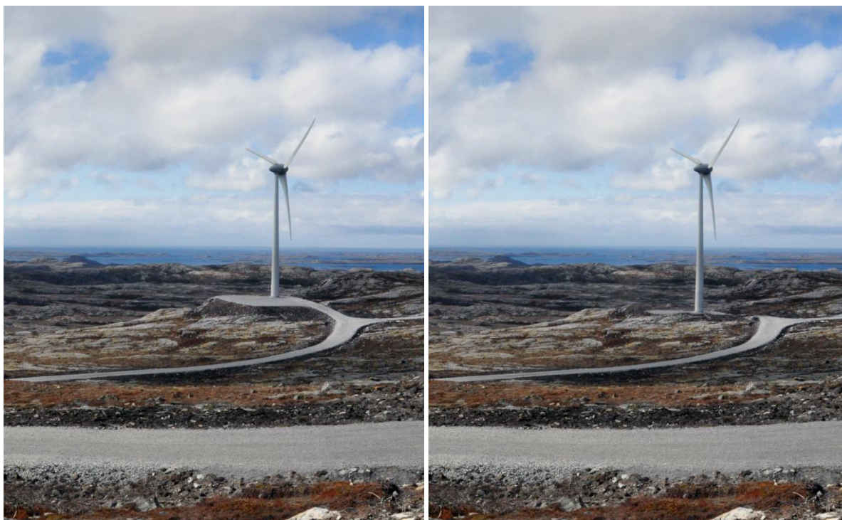
Figur 27. Minst mulig eksponering av kranoppstillingsplass og fundament er viktig for god landskapstilpassing, her vist ved senking av oppstillingsplass slik at utstrakte fyllinger unngås og gjenstående knauser delvis skjerner for innsyn.
