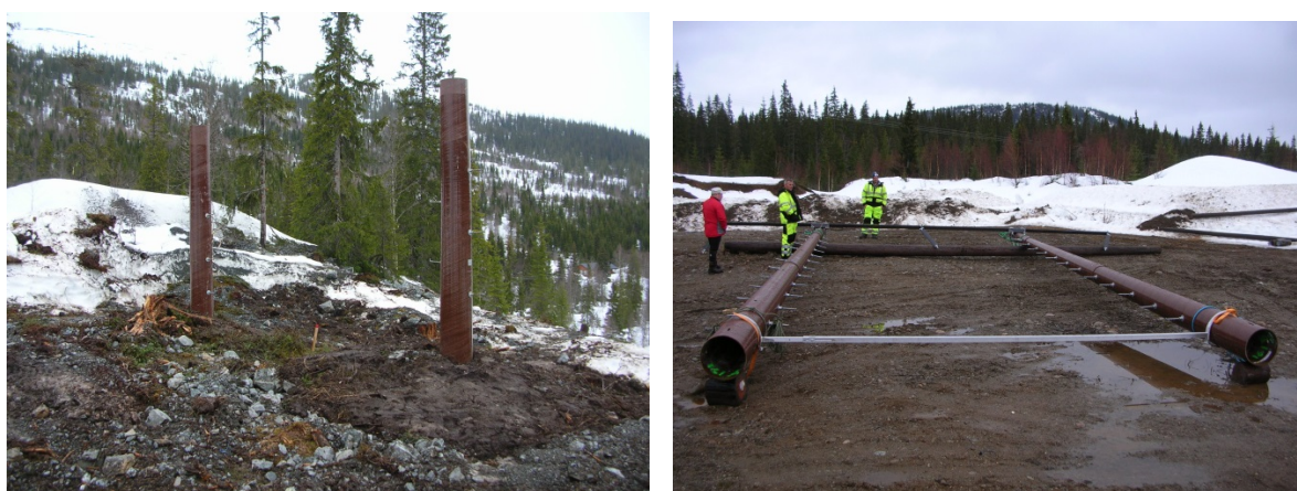
Figur 2: Bilde av ferdige fundament og ferdig montert, mast klar for å flys ut med helikopter
