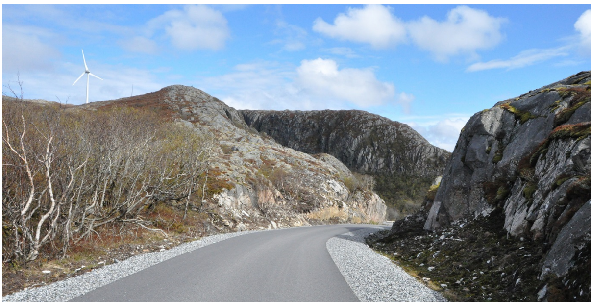
Figur 14. Dersom vegen må føres gjennom fjellparti og tosidige skjæringene ikke kan unngås, er det viktig at det settes av nok plass til at tverrsnittet føles romslig og skjæringene kan bearbeides i bunn og topp for å minske deres visuelle høyde og myke opp profilet. (Originalbilde fra asfaltert adkomstveg til vindkraftverket på Ytter Vikna)
