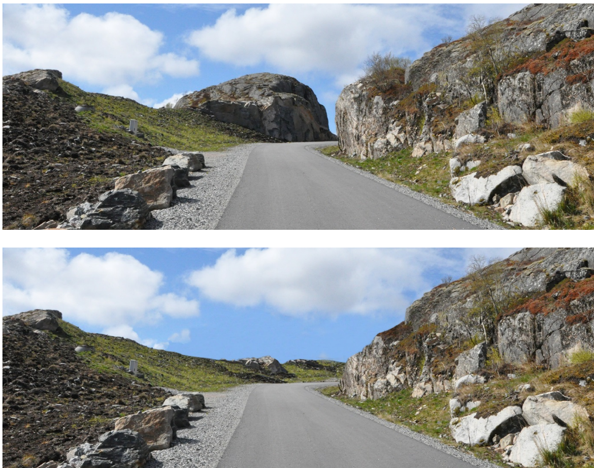
Figur 21. Ved behov for ekstra masser tas positive former ut i sin helhet. I det manipulererte bildet under er en større gjenstående knaus etter innføring av atkomstveg benyttet, samtidig som man har tatt toppen av skjæringa på motsatt side. Mindre knauser har fått stå igjen for variasjon og en mer naturlig flate.
