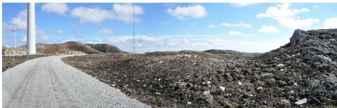
Figur 7. Fotomanipulert bilde viser at en mindre overhøyde på deler av arrondert terreng kan være alt som skal til for et mer naturlikt landskapsbilde
