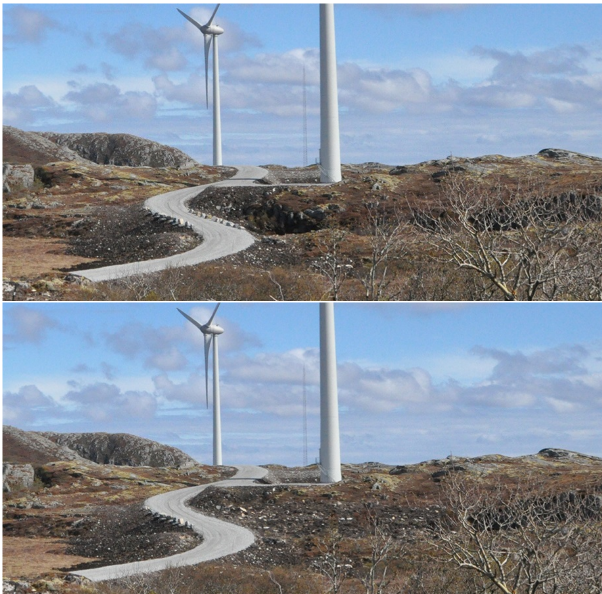
Figur 22. I det fotomanipulerte eksempelet er det fylt igjen masser i et dalsøkk foran fremre turbin. Her ville dette samtidig gitt vegen en bedre forankring i landskapet ved å unngå fyllingsskråning på begge sider av vegen og kranoppstillingsplassfor turbinen blir mindre ruvende.
