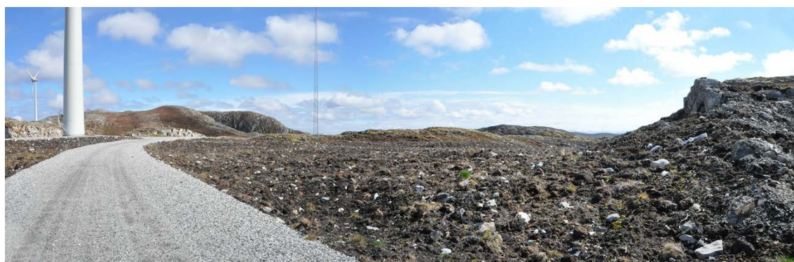
Figur 6. Istandsatt massetak har fått ei overflate som går fint til tiliggende terreng, men flata er noe stor og ensarta til at den visuelt aksepteres som en naturlig formasjon i det småkuperte terrenget.
