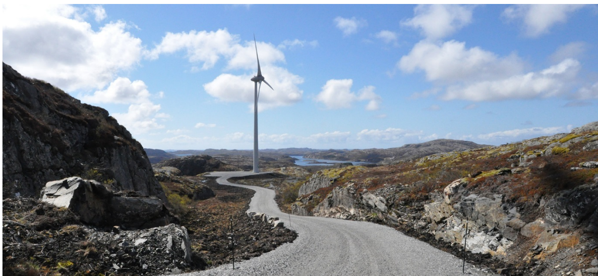
Figur 10. Dersom vegen ikke forankres i eksisterende terrengformer, men blir liggende med tosidig skjæring eller fylling vil den bli mer markant i landskapsbildet, som her hvor vegen blir liggende med tosidig fylling i et lokalt lavpunkt.
