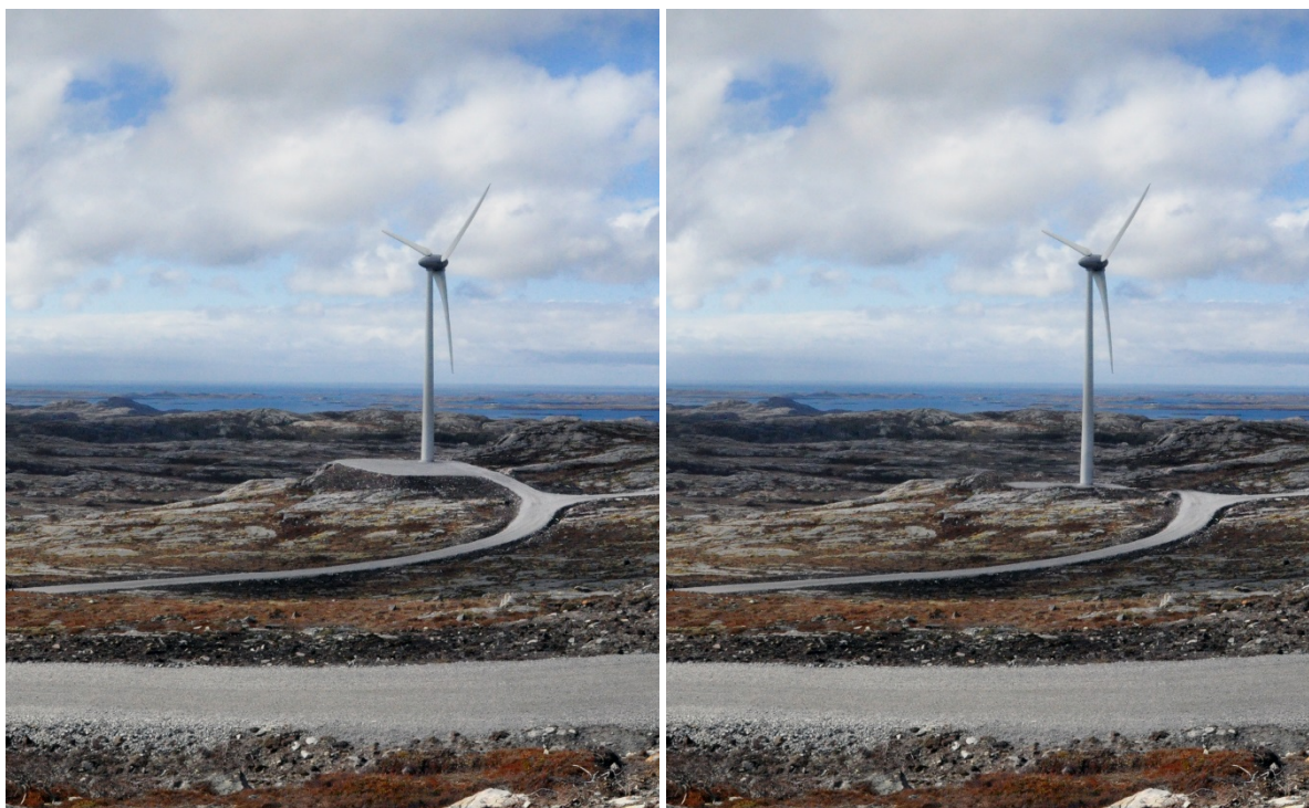
Figur 26. Minst mulig eksponering av kranoppstillingsplass og fundament er viktig for god landskapstilpassing, her vist ved senking av oppstillingsplass slik at utstrakte fyllinger unngås og gjenstående knauser delvis skjermes for innsyn.
