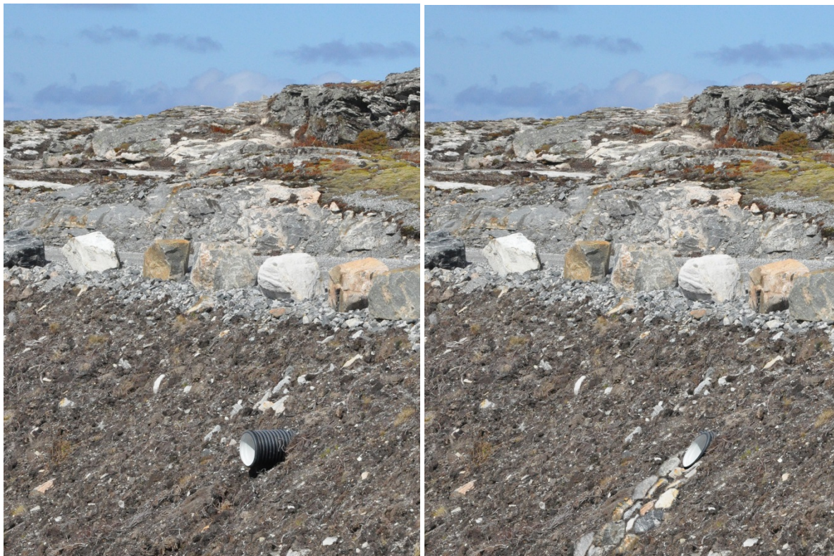
Figur 20. Der stikkrennene ender ut i en skråning er det viktig å plastre i nedkant for å hindre uønsket erosjon over tid.
