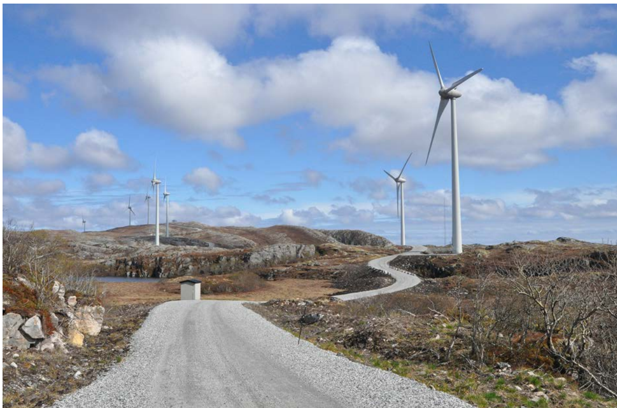
Figur 11. I det småkuperte landskapet er økt veglengde å foretrekke foran skjæringer i tillegg kan traseen med fordel legges med litt høyde i terrenget, da fyllinger i prinsippet lettere kan gis en naturlig tilpassing enn skjæringer.
