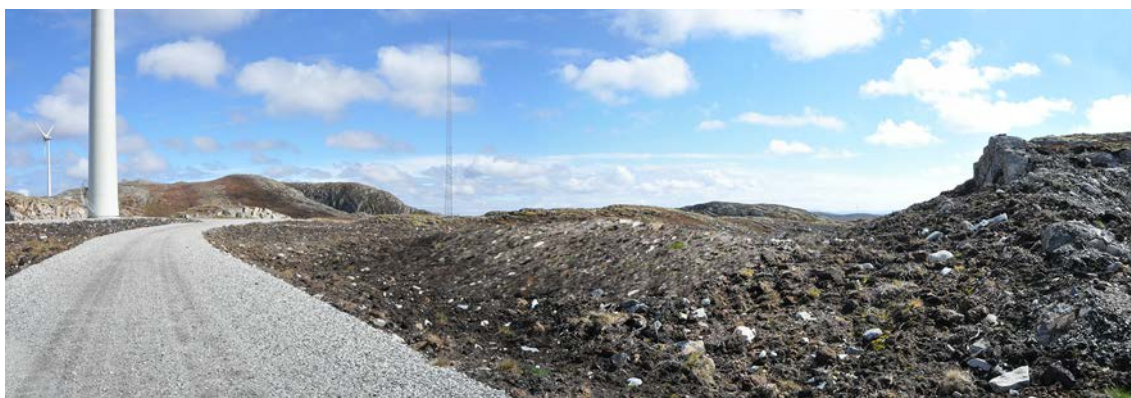
Figur 7. Fotomanipulert bilde viser at en mindre overhøyde på deler av arrondert terreng kan være alt som skal til for et mer naturlikt landskapsbilde
