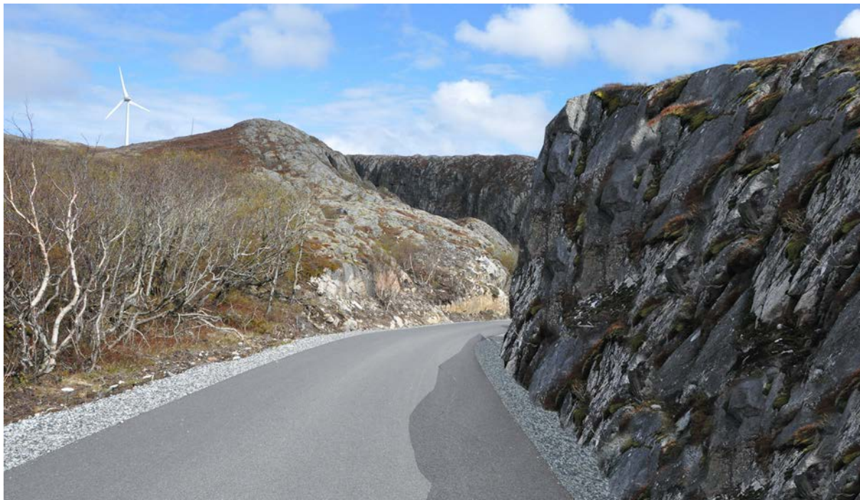
Figur 13. Manipulert bilde viser en tosidig skjæring der det ikke er gjort tiltak for å dempe den visuelle virkningen av skjæringen til høyre i bildet.
