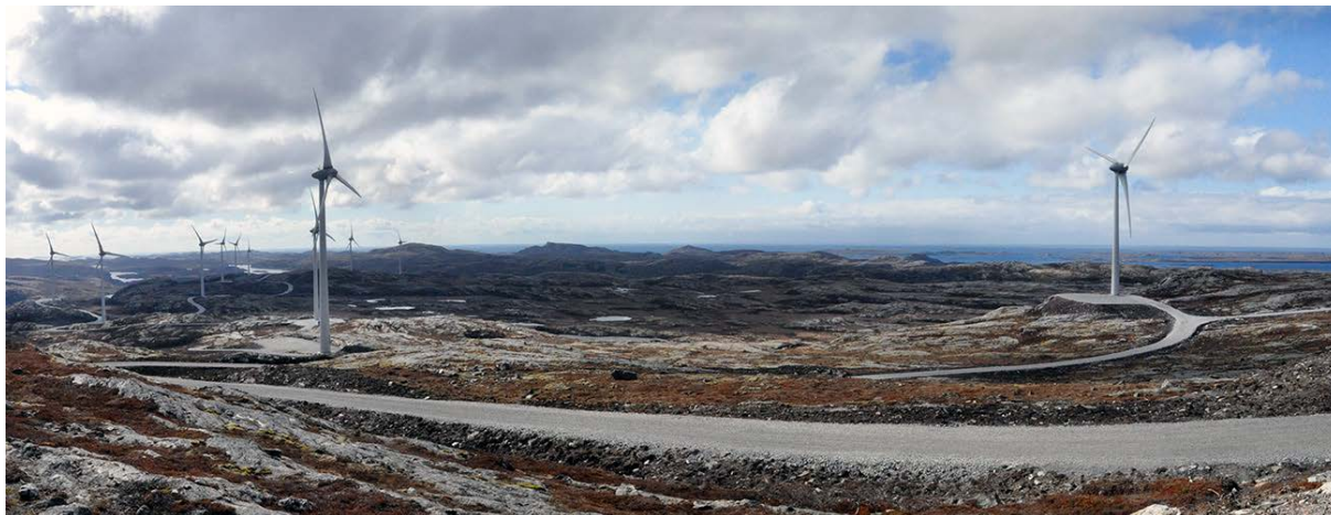
Figur 25. Panoramabildet viser kranoppstillingsplasser som generelt ligger godt i terrenget, med unntak av den ved vindturbinen til høyre i bildet som ligger noe høyt og blir dertil eksponert.
