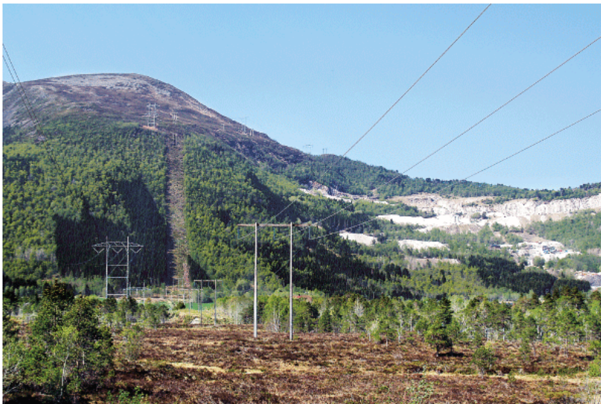
Figur 24. Bildet viser parallellføring av to ledningstraseer, der linja til venstre i bildet har begrensa skogrydding og er langt mindre synlig enn linja til høyre. (Foto: Statnett)
