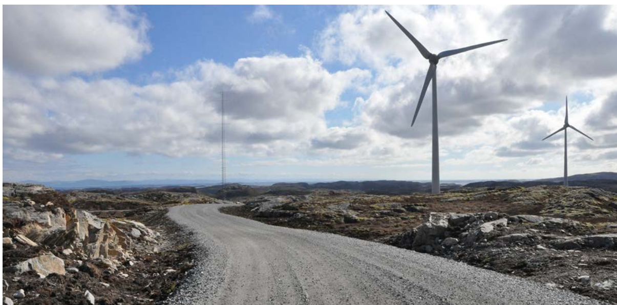
Figur 18. En mindre skjæring står igjen på venstre sida av vegen. Mindre pigging i toppen, som vist på manipulert bilde nederst, er alt som skal til for at oppstikkende nabber på begge sider av vegen skal bli mindre påfallende.
