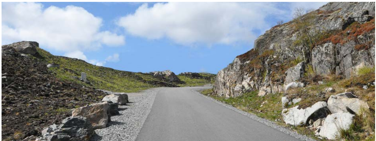
Figur 21. Ved behov for ekstra masser tas positive former ut i sin helhet. I det manipulererte bildet under er en større gjenstående knaus etter innføring av atkomstveg benyttet, samtidig som man har tatt toppen av skjæringa på motsatt side. Mindre knauser har fått stå igjen for variasjon og en mer naturlig flate.
