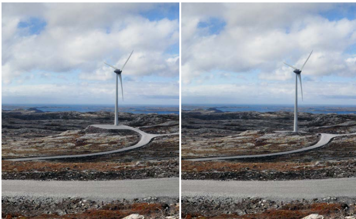
Figur 26. Minst mulig eksponering av kranoppstillingsplass og fundament er viktig for god landskapstilpassning, her vist ved senking av oppstillingsplass slik at utstrakte fyllinger unngås og gjenstående knauser delvis skjermes for innsyn.
