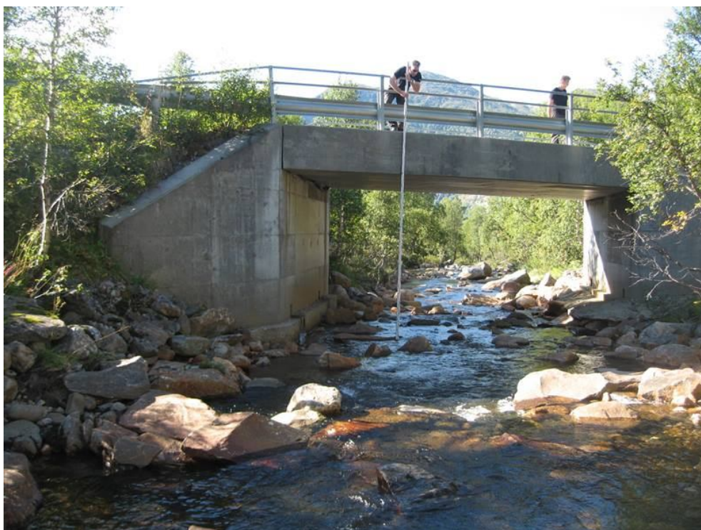
Bilde 19: Bru (H=3m, B=6m) der Stavnesveien krysser elva. Foto: Clemens Elvekraft.
