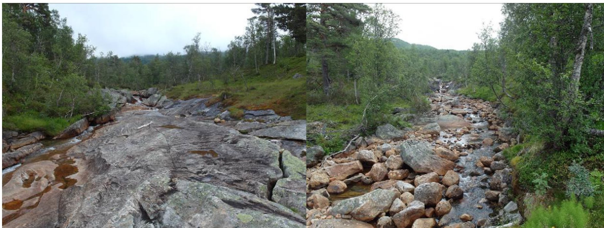
Bilde 4.18 (venstre) og 4.19 Fra øvre del av fallstrekningen. I bakgrunnen i bildet til høyre sees stedet der inntaket er tenkt plassert.
