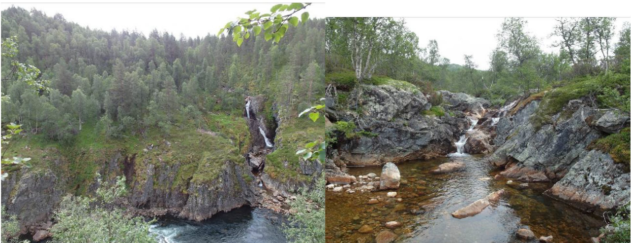
Bilde 2.1 (venstre) Område for kraftstasjon (50-60m oppstrøms utløpet av Tveiteråni i Otra) Bilde 2.2 (høyre) Inntakssted
