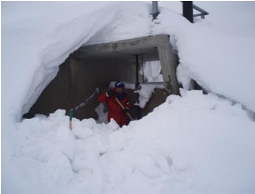
Figur 3. Åpning for slipp av sommerminstevannføring ved inntak Ya 30. april 2010.
