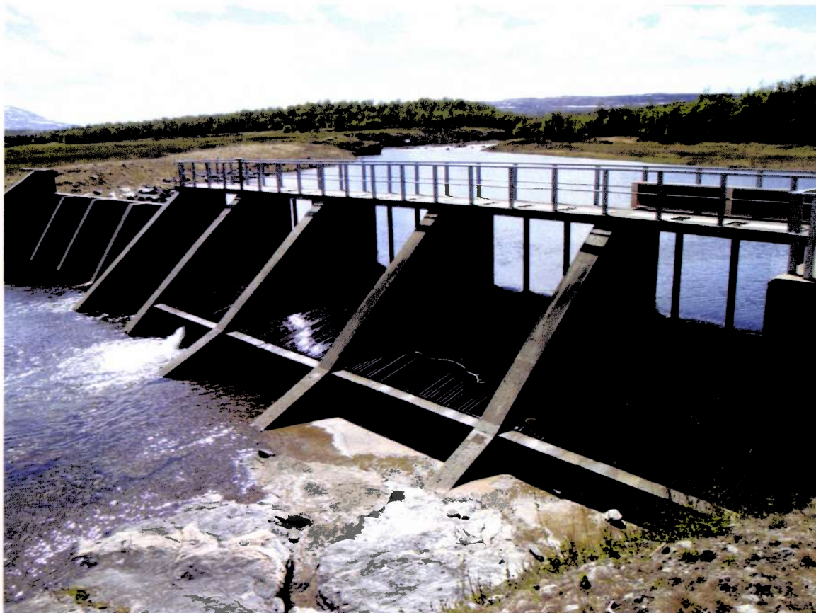
Figur 26: Inntaksdam med minstevannføringsslipp ved Øvre Dølvad.
