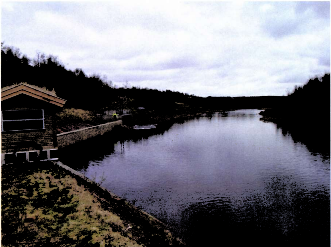
Figur 28: Inntaksdammen i Ya.
