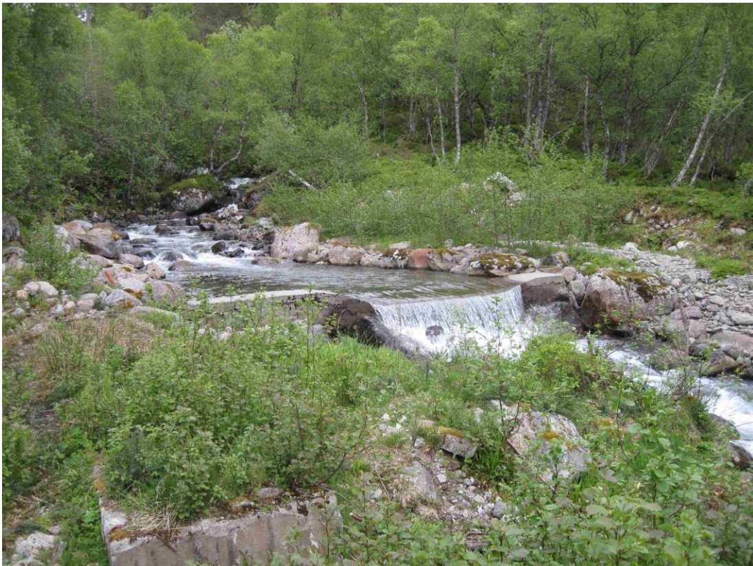
Inntaksområde for Nedre Huna Kraftverk. Utsikt oppstrøms dam.
