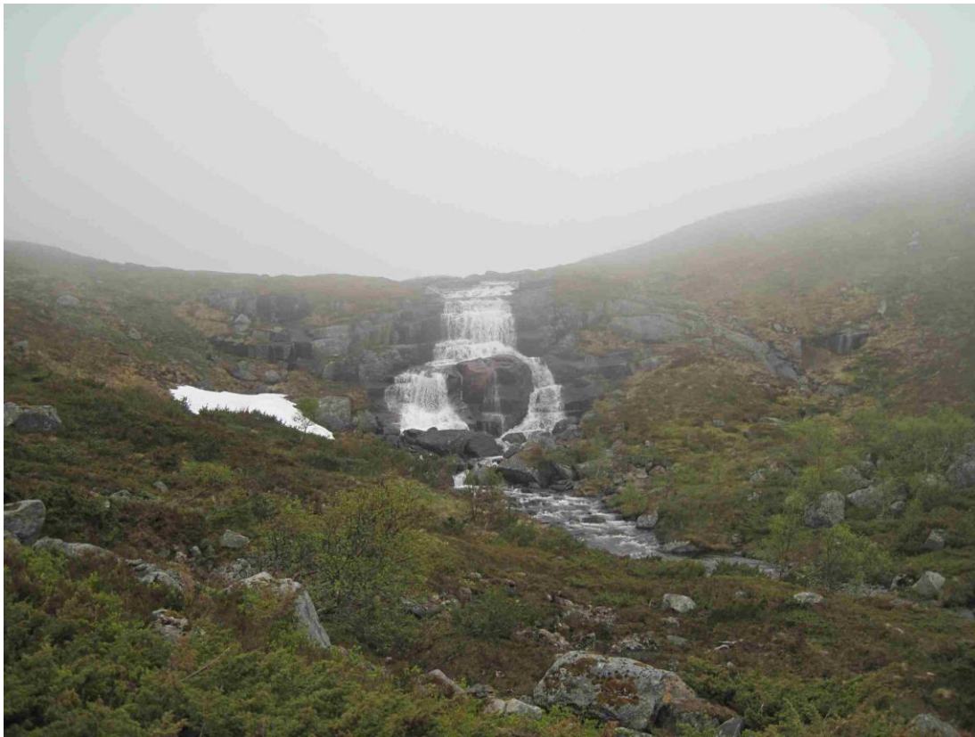
Utsikt oppstrøms inntaksdam for Øvre Huna Kraftverk
