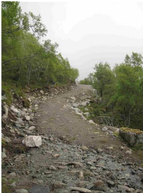
Figur 2.14: Rørtraseen for Øvre Huna legges langs veien.
