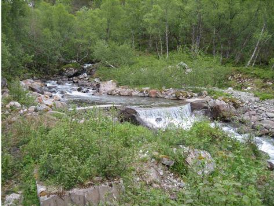
Figur 2.11: Utsikt oppstrøms inntak, Nedre Huna.
