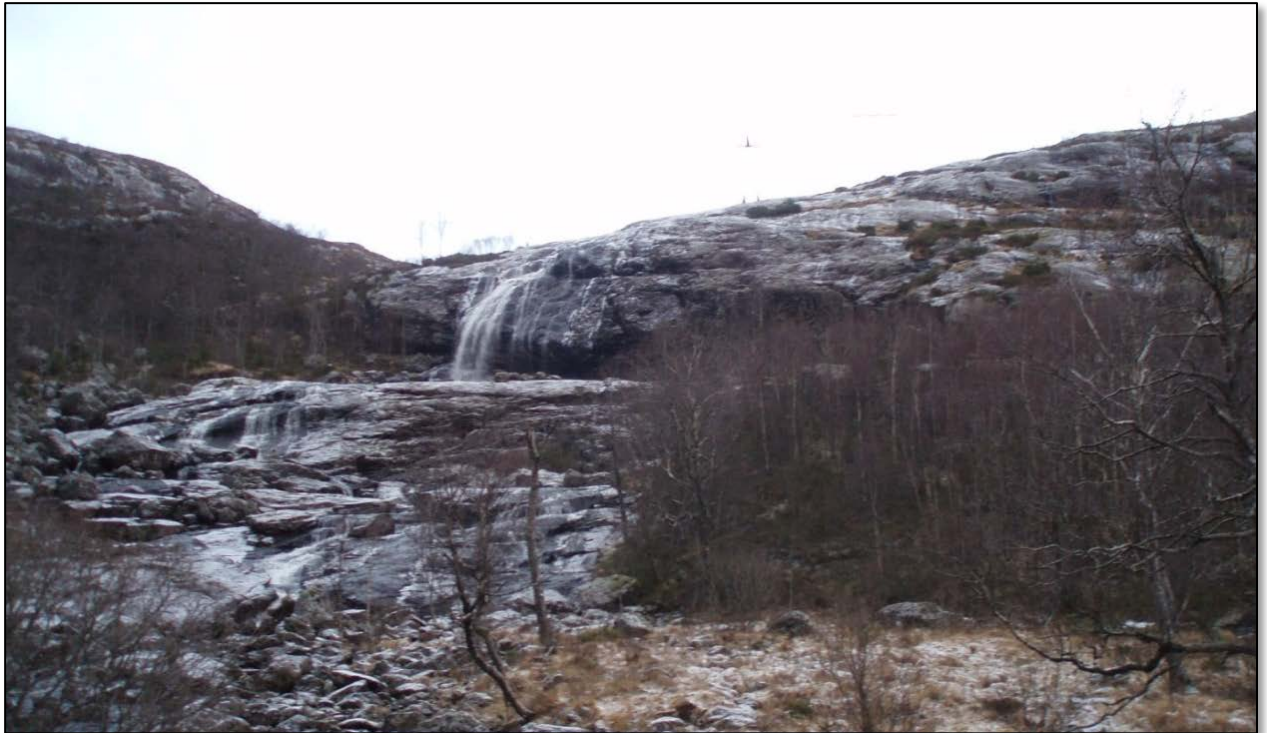
Figur 35. Fossedalsfossen ved anslått vannføring på 200 l/s.
