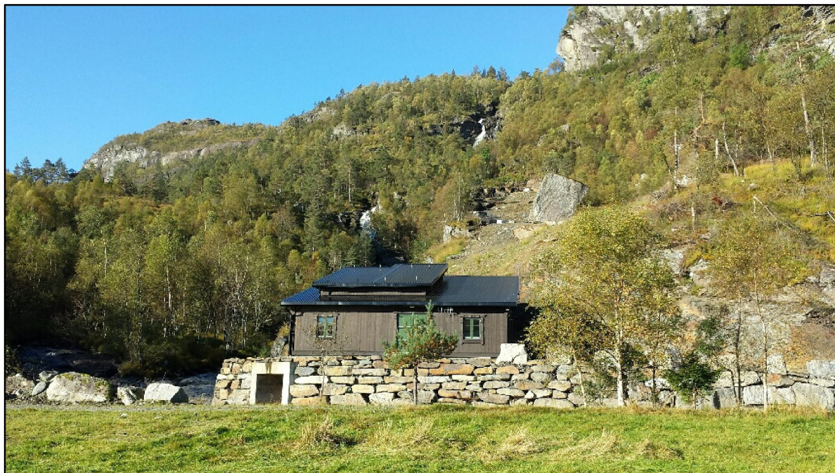
Figur 2-9 Eksempel på Stasjonsbygg.
