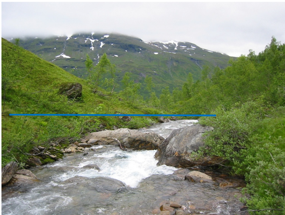
Figur 2-5 Inntaksdam på kote 240.
