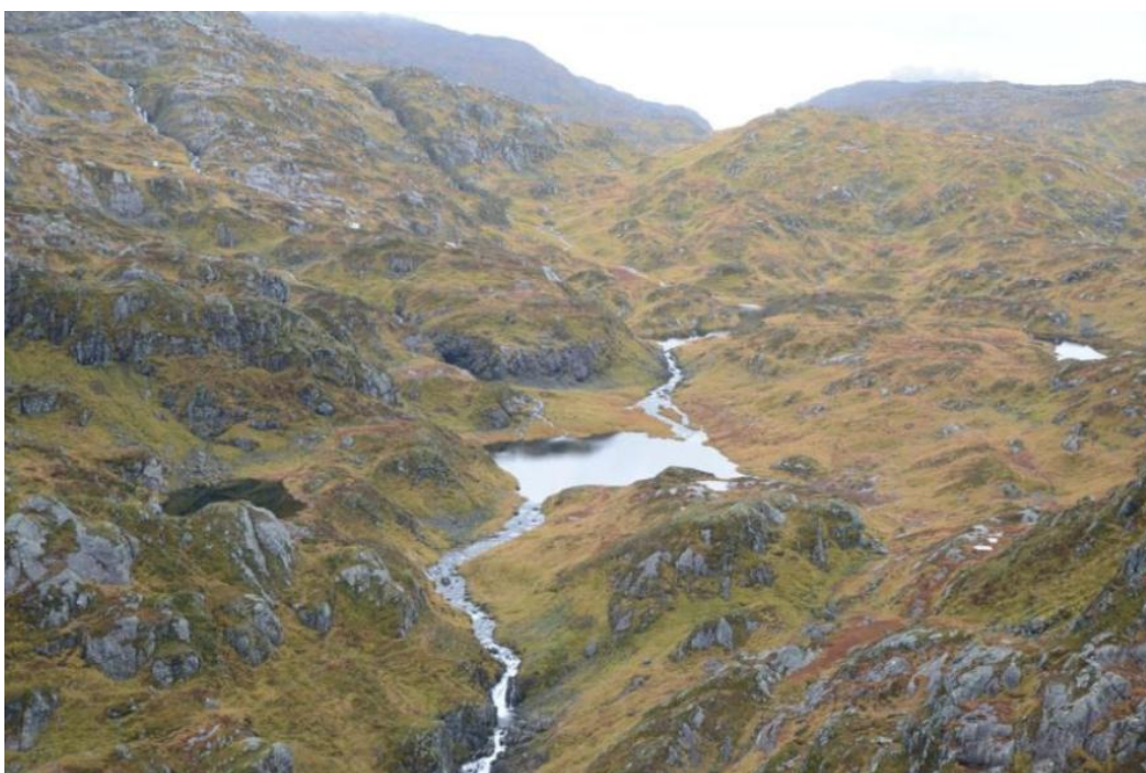
Figur 5 Inntak Kvanngrodhorga. Det er tenkt en ca. 2–3 m høy sperredam like nedstrøms utløpet av vannet. Inntaket skal plasseres på et egnet sted avhengig av grunnforhold og plassbehov. Bilde: SKL Produksjon AS.
