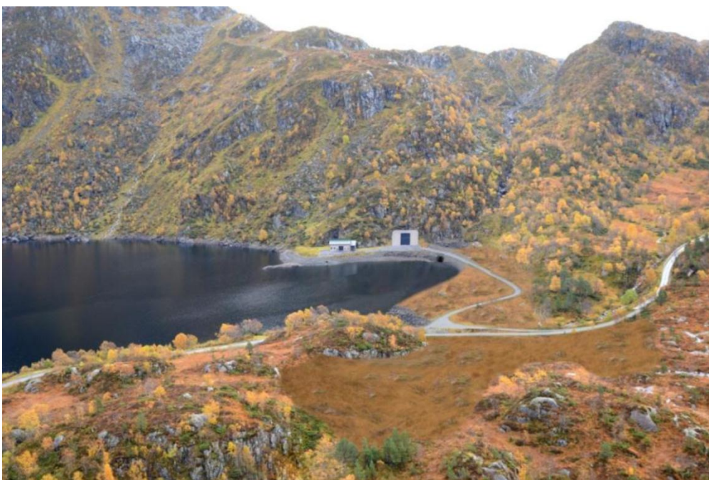
Figur 9 Adkomsttunnel med portalbygg og med eksempel på massedeponi Staffivatn før og etter inngrep. Endelig plassering og utforming av massedeponiet bestemmes ved utarbeidelse av Landskap- og miljøplan. Visualiseringen gir et inntrykk av hvordan et massedeponi ved Staffivatn kan utformes.
