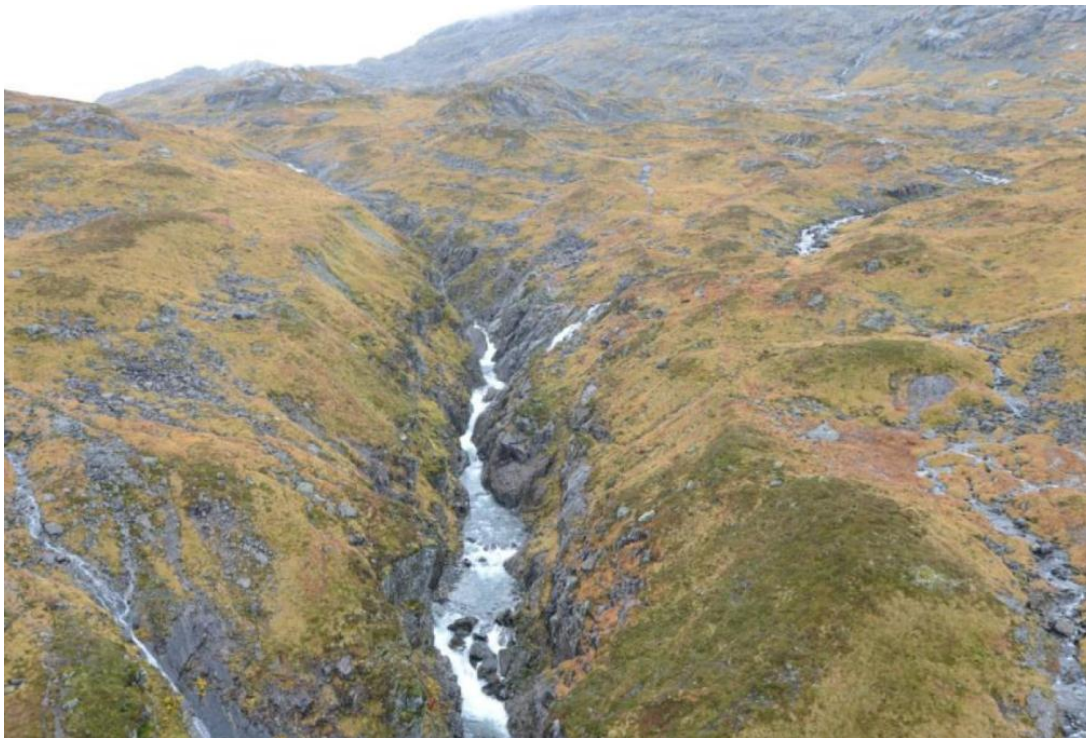
Figur 12: Inntak Krokavatn, sett mot sør. Inntaket er tenkt nedstrøms bekken som kommer fra vest/høyre. Foto: SKL
