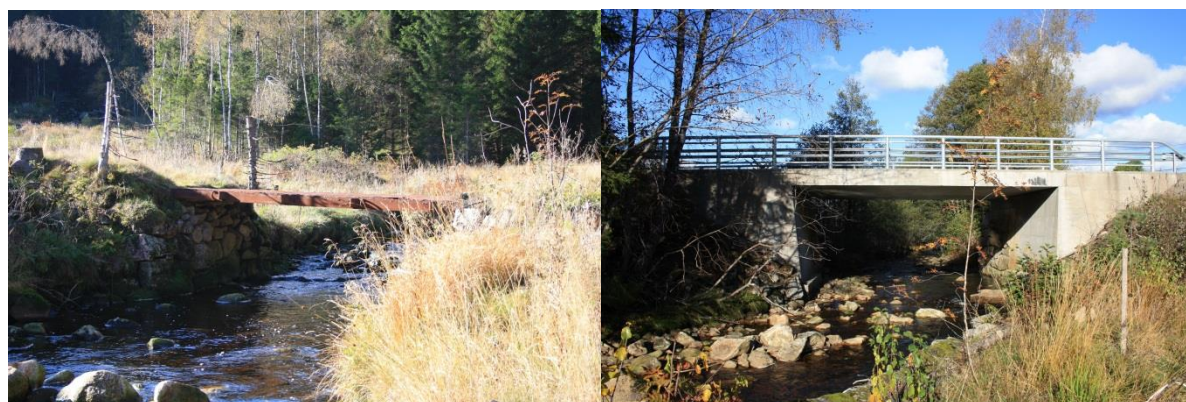
Figur 7: Bru over Skuåna ca. midtveis i influensområdet. Til høyre: FV455 i bru over Skuåna nedstrøms kraftstasjonen. Foto: Anne Nylend.
