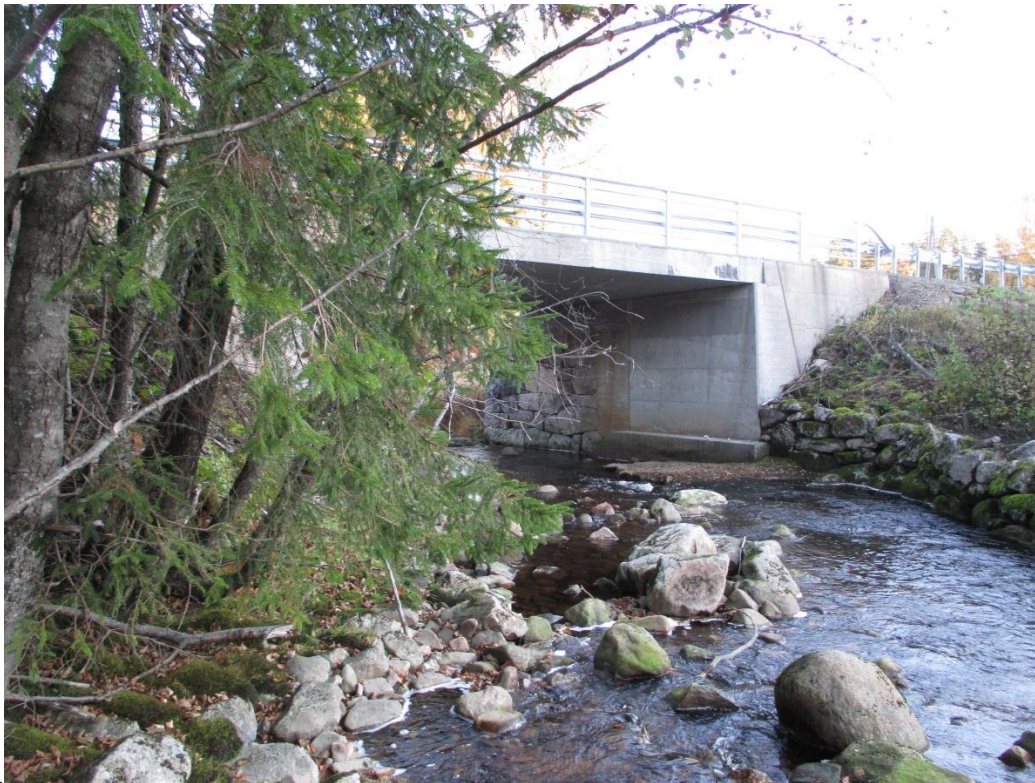
Bilde nr. 2. Kulvert under Riksveg 455, nedstrøms stasjon
