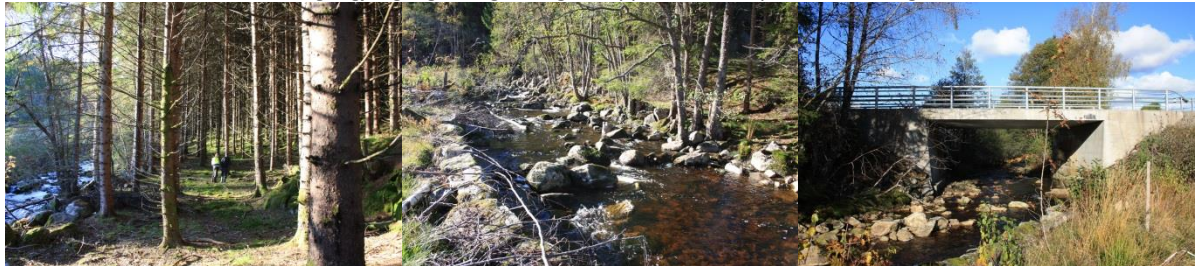
Kraftstasjonen med avløpskanal plasseres ca 50 m ovenfor brua/fylkesvei 455. Skogen er ensartet og fattig granskog.
