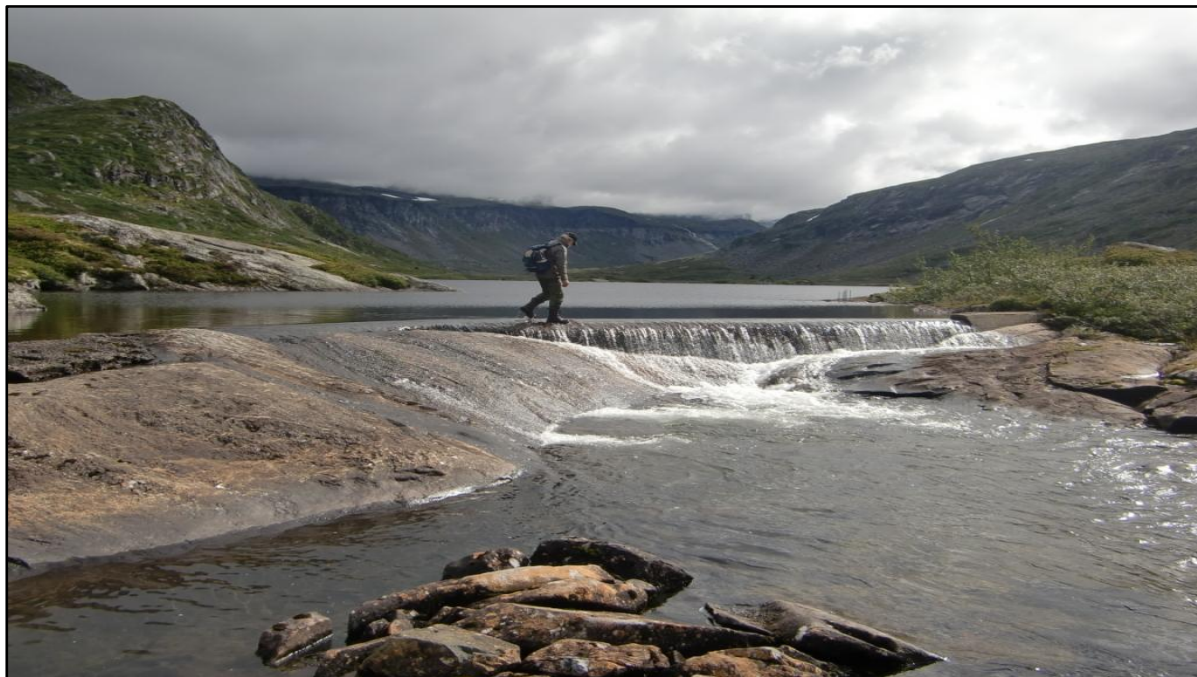
Figur 3.5 Dagens terskel ved utløpet av Skytjedalsvatnet. Denne vil bli forlenget og hevet.
