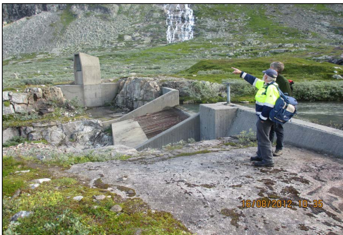
Figur 3.7 Bekkeinntaket i Skytjedalselva på overføringstunnelen til Rembesdalsvatnet og Sy-Sima kraftverk.
