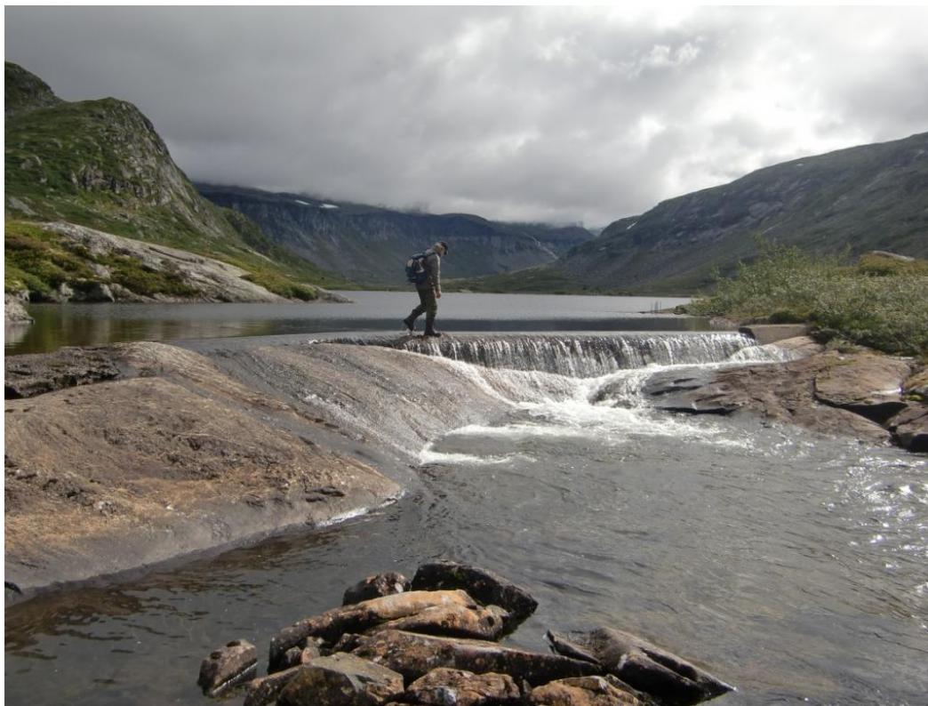
Figur 3.2. Eksisterende terskel i utløpet av Skytjedalsvatnet
