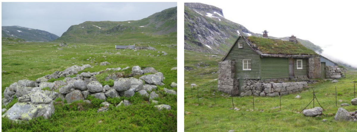
Figur 6.11. Ruiner (til høyre) etter tidligere stølshus og SEFRAK-bygg som ennå er i bruk (til venstre) på Skytjedalsstølen. I bakgrunnen på bildet til venstre kan eksisterende stølshus skimtes.
