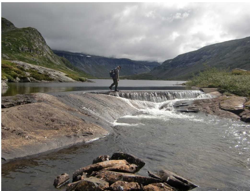
Figur 3.2. Eksisterende terskel i utløpet av Skytjedalsvatnet
