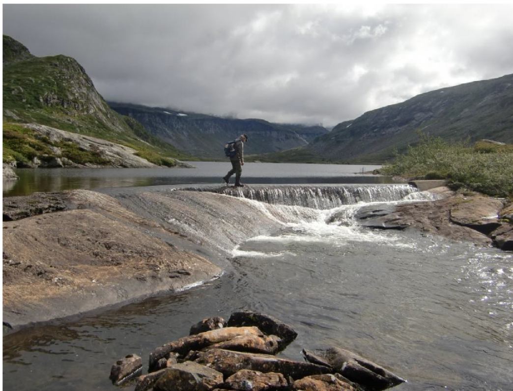
Figur 3.2. Eksisterende terskel i utløpet av Skytjedalsvatnet
