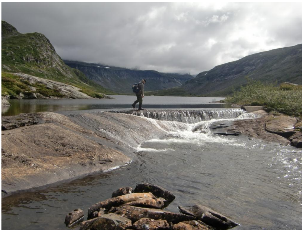
Figur 3.2. Eksisterende terskel i utløpet av Skytjedalsvatnet
