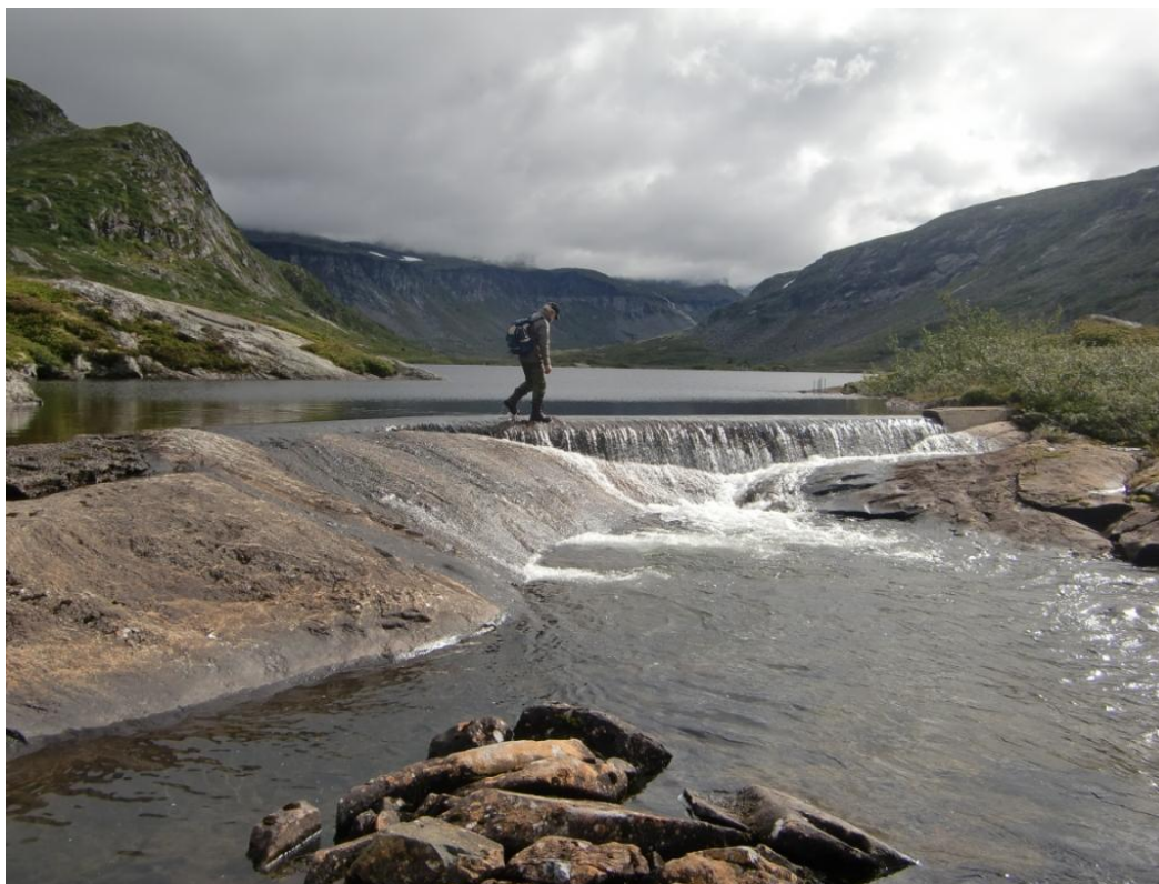
Figur 3.2. Eksisterende terskel i utløpet av Skytjedalsvatnet
