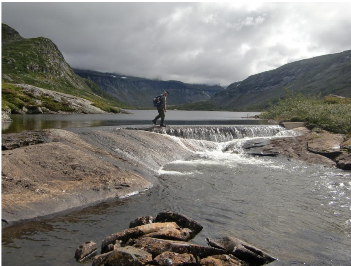
Figur 3.2. Eksisterende terskel i utløpet av Skytjedalsvatnet
