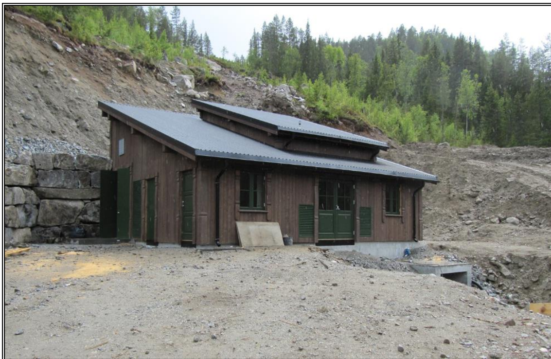
Figur 2.15 Eksempel på stasjonsbygg
