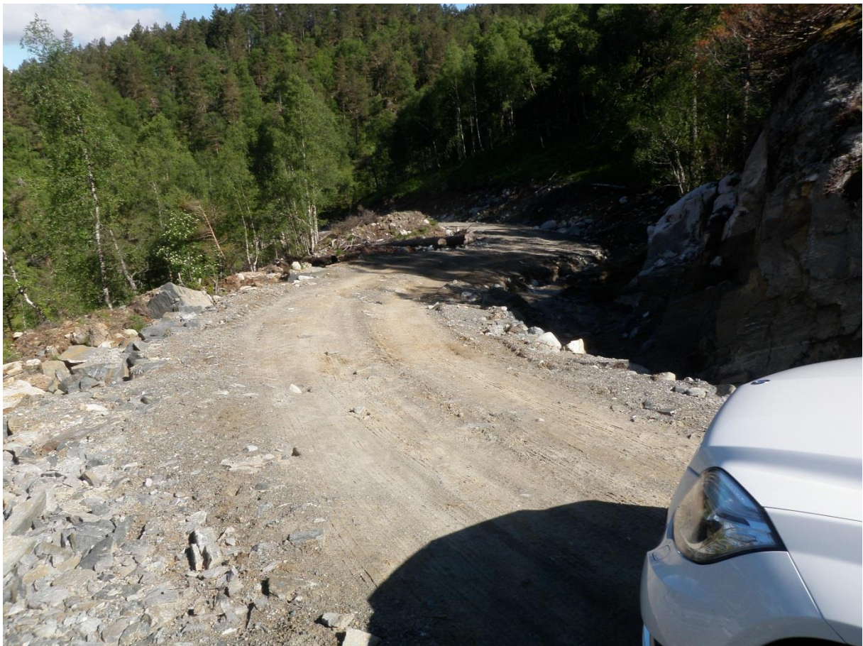
4. Opparbeidet anleggsvei ved inntak
