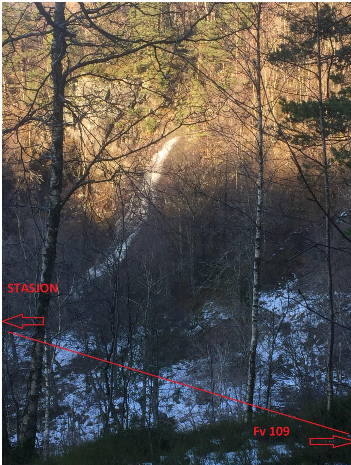
Figur 2.11 Område for rørgate sett fra anleggsvei ned mot stasjonstomt
