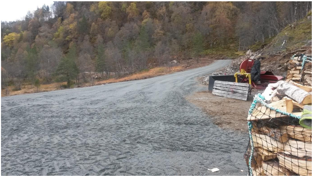
3. Enden av anleggsvei forbi inntak
