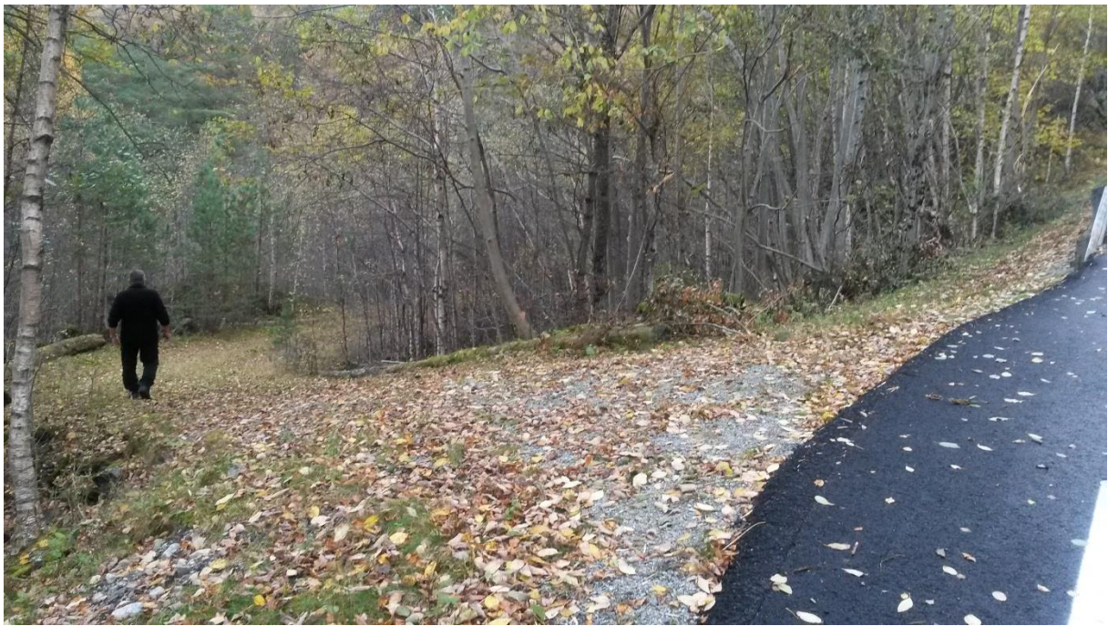
9. Anleggsvei ned mot stasjonstomt, avkjørsel fra Rv
