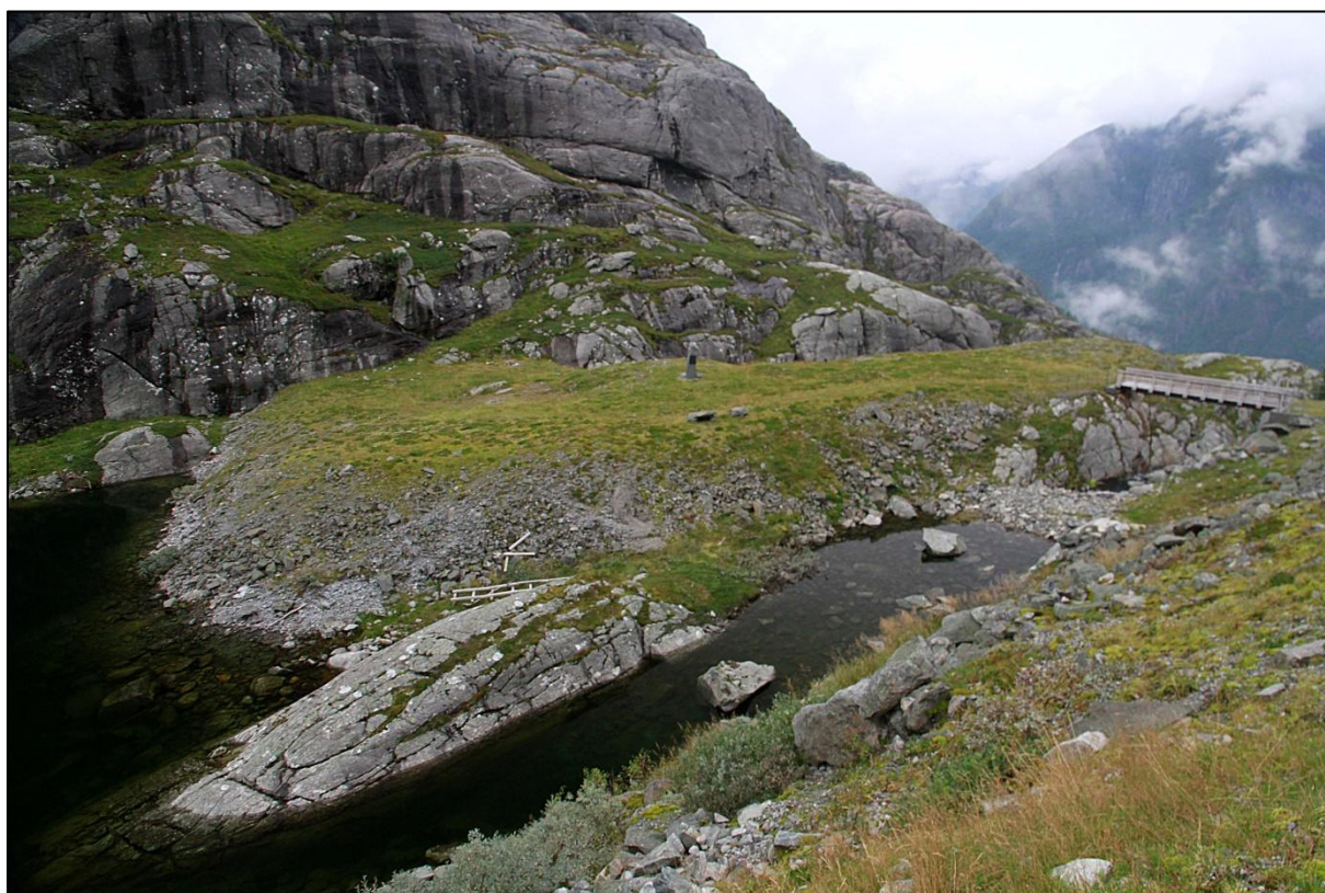
Fig. 10. Rennedalsvatnets utløp med eldre massedeponi. Dam i planlagt magasin lokaliseres her (allerede en liten terskel anlagt knyttet til tidligere anleggsarbeid). Kartlagt sone 1 og 2. 25. august 2016. Foto: A. Håland.
