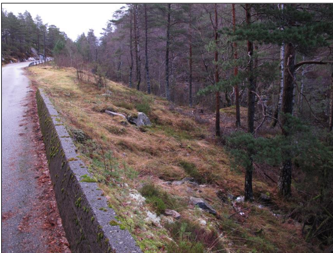
Oversiktsbilde nedre del av rørgate/stasjon
