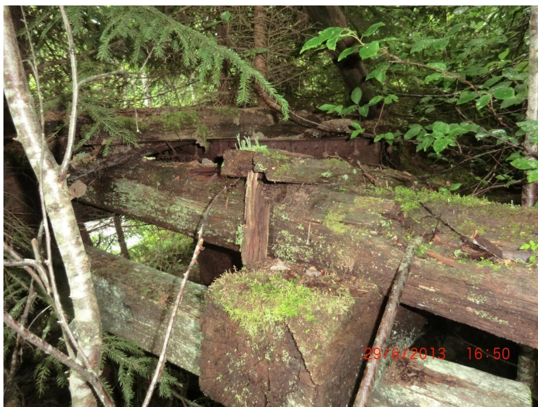
Bilde 6: Rester etter kraftverk nedlagt på 1950 tallet. Dagens kraftverk vil plasseres omtrent på samme sted, benytte samme inløpskanal og samme utløpskanal.
