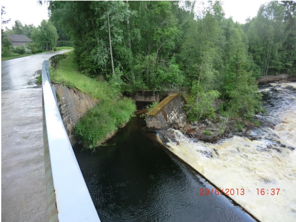
Bilde 1: Eksisterende dam sett fra bro. Inntak gammelt kraftverk til venstre. Her blir også nytt inntak. Dammen skal kun rehabiliteres – inntak renses for vegetasjon og for en del bunnslam.
