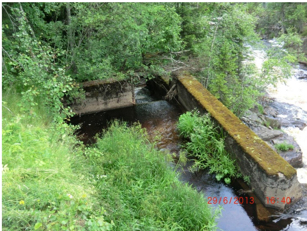
Bilde 2: Gammelt inntak. Her blir også det nye inntaket. Kanal lages mot vannkraftskrue.
