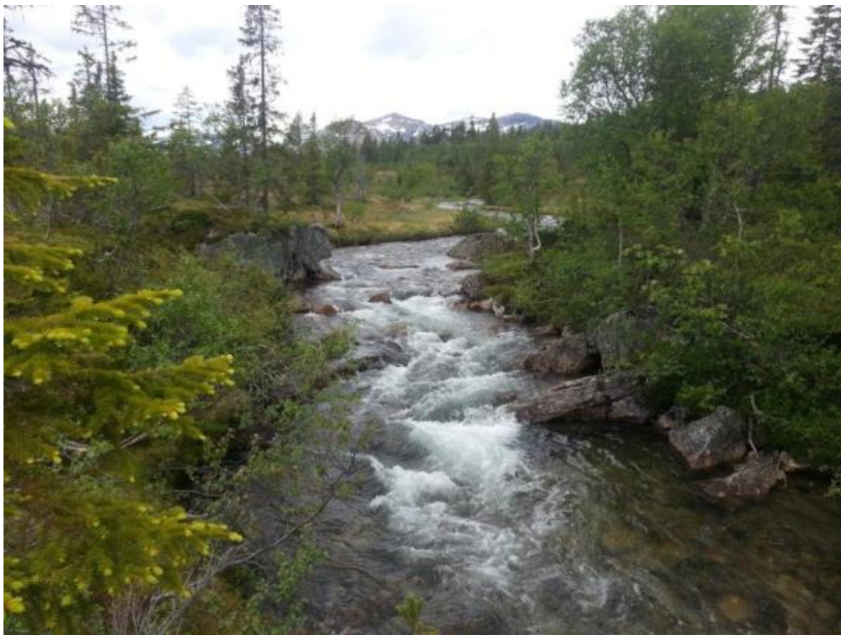
Bilde 1: Parti ved inntaket. Bildet er tatt i juni 2013 og vannføringen er estimert til ca. 3000 liter/sekund.
