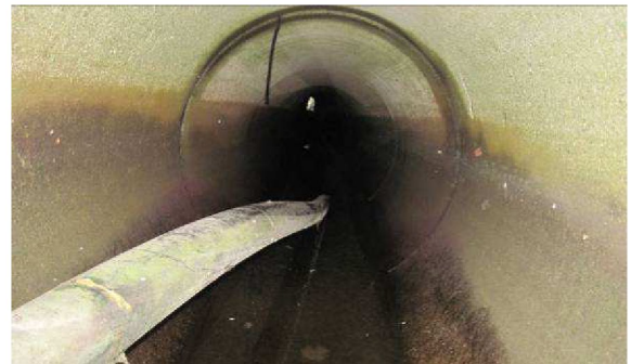
Figur 13 Blikk gjennom kulverten
