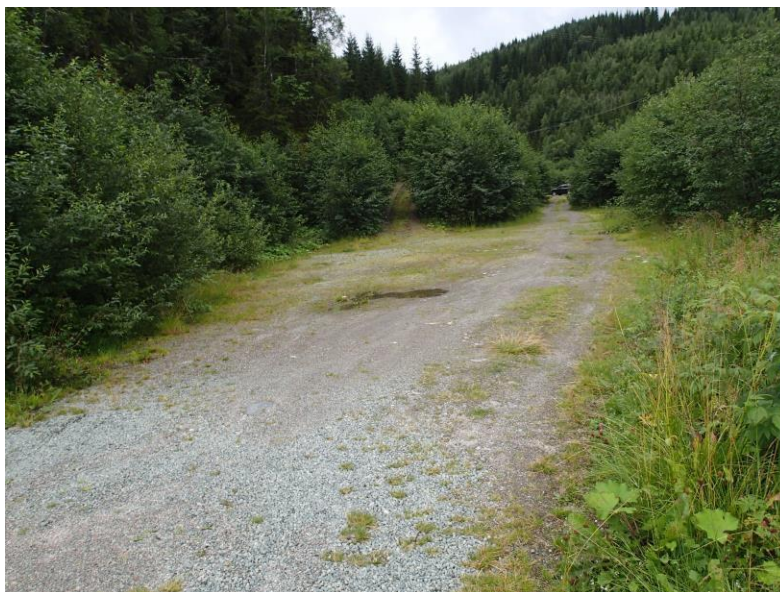
Figur 3-6 Skogsbilvei fra riksvei og opp mot eksisterende inntaksdam.
