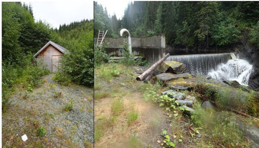
Figur 1-2 Bilder av eksisterende kraftanlegg i Ytteråa. Til venstre: eksisterende kraftstasjon. Til høyre: eksisterende inntaksdam.
