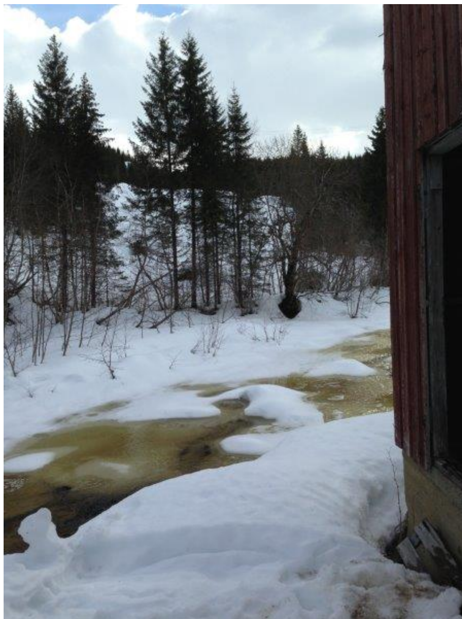
Figur 12a: Ved kraftstasjonen, bilde tatt i april 2013. Q =
