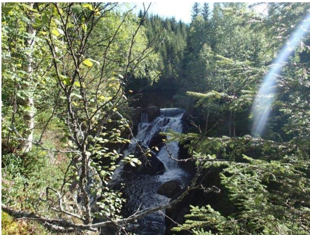
Figur 2-4 Eksisterende inntaksdam som opprustes og benyttes videre.
