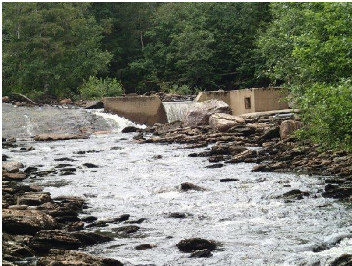
Figur 3: Eksisterende dam for fiskeanlegg (nedlagt).
