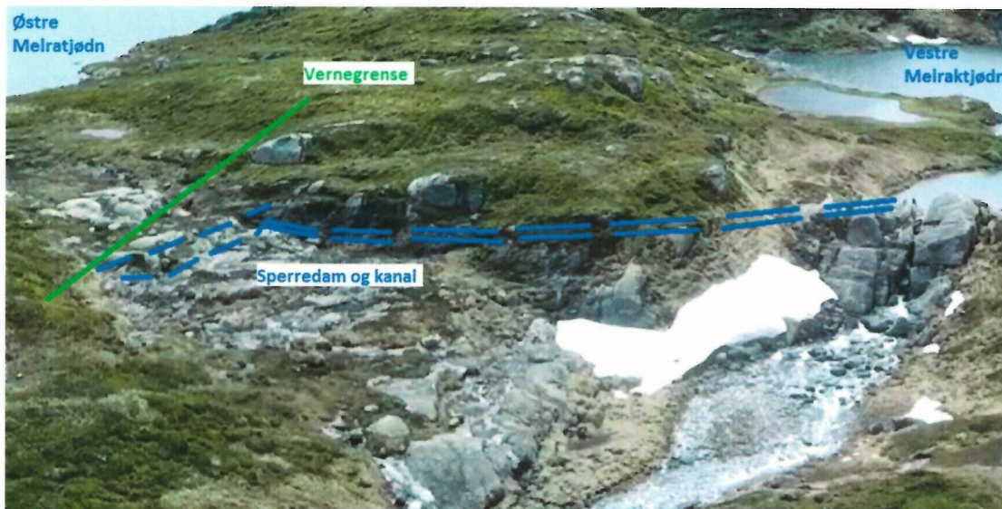
Figur 4: Sperredam og rør i skjæring (alternativ 1).
