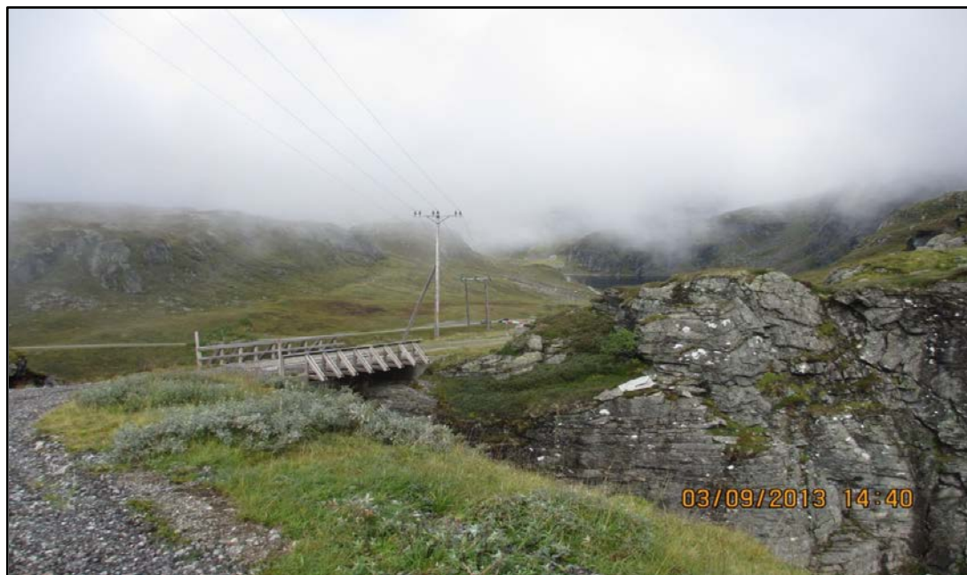
Figur 2.3 Anleggsveien opp til Svartedalsvatndammen
