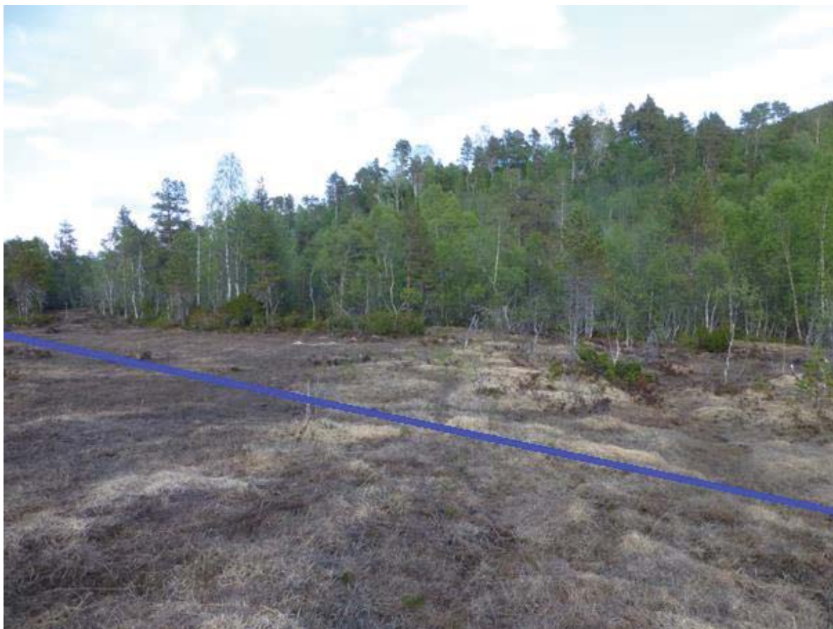
Figur 6. Typisk terreng for rørgatetrasé.
