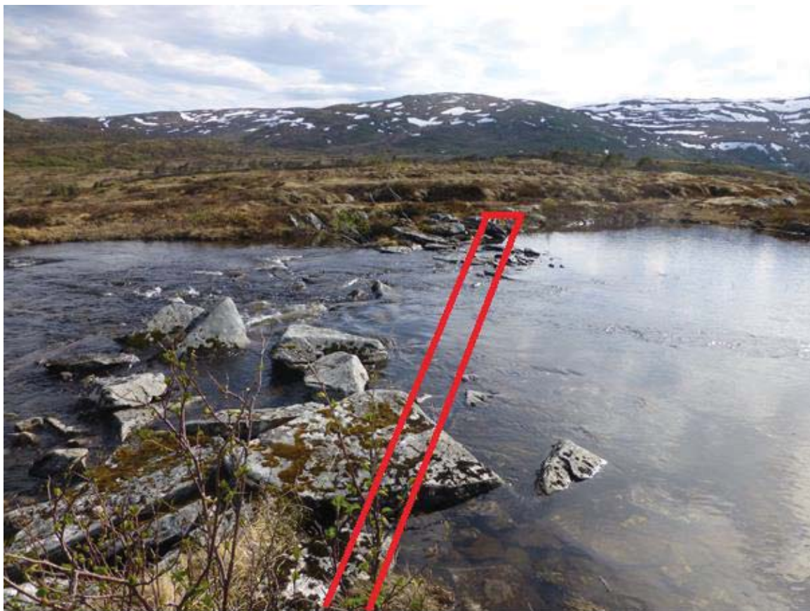
Figur 1. Dam ved utløpet til Leiråvatnet.
