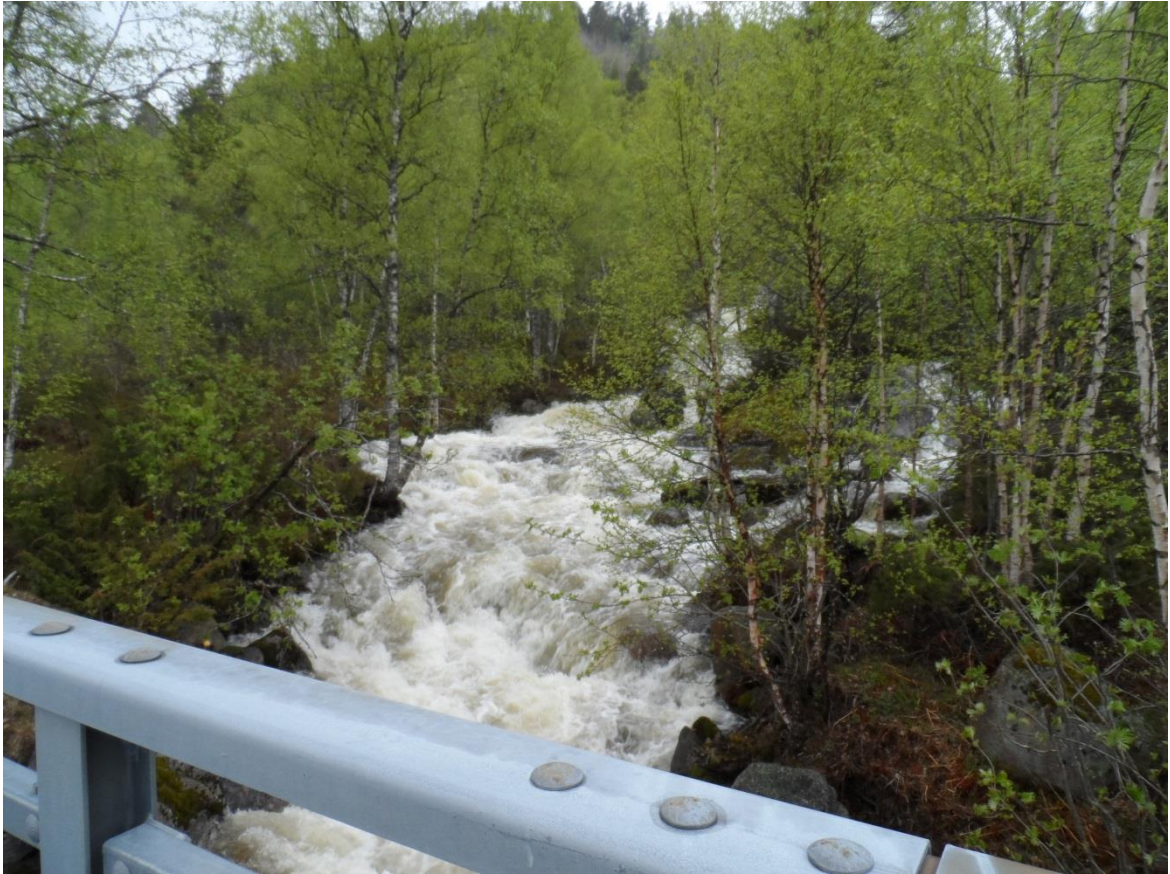
Bilde viser nedstrøms kraftstasjon der bru (fylkesvei 352) krysser Bliksåna
