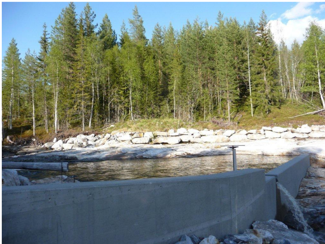
Bilde 1-8. Kraftstasjon er tenkt plassert i skogen til venstre i bildet.
