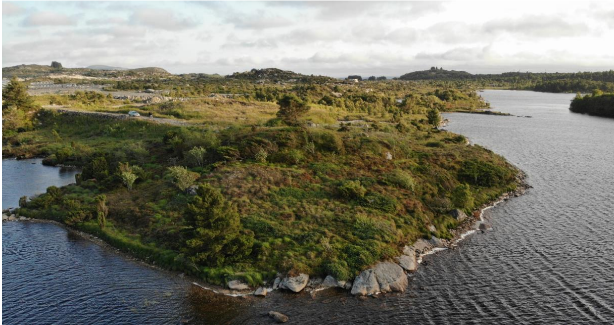
Bilde 2: Etablert anleggsvei i sørlig del av næringsparken, i bakgrunnen skimtes planerte områder og lagrede brakker.
