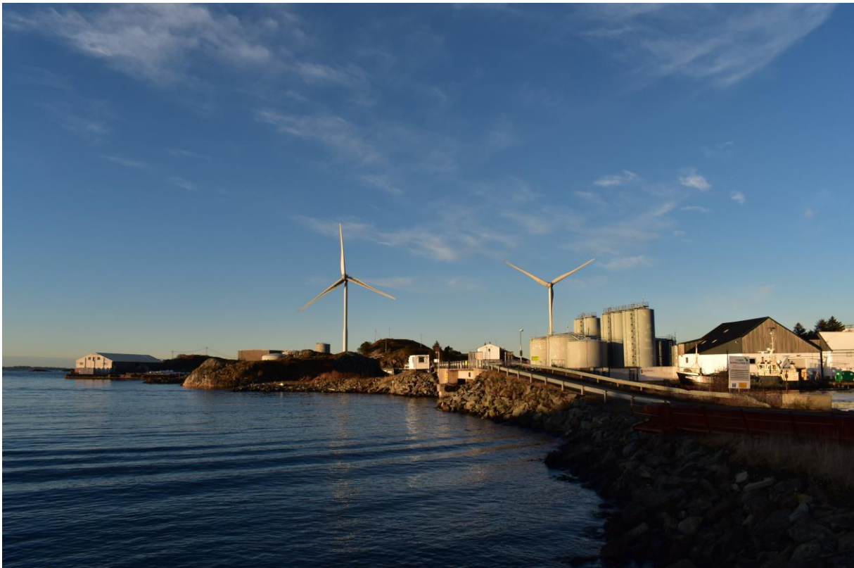
Bilde 4: Vindturbiner (Enercon E-115 med 92 m navhøyde og 115 m rotordiameter) i Storøy Næringspark (Karmøy kommune). Avstand til nærmeste bedrift ca. 220 m.
