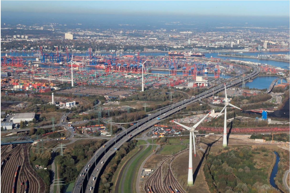
Bilde 5: Vindturbiner i havneområde i Hamburg, Tyskland.
