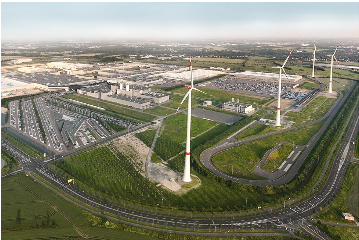
Bilde 6: Vindturbiner i BMW fabrikk i Leipzig, Tyskland. Avstand fra nærmeste turbin til parkeringsplass er ca. 110 m. Turbiner ha en navhøyde av 140 m og 100 m rotordiameter (Nordex N-100). (Bilde: BMW Group)
