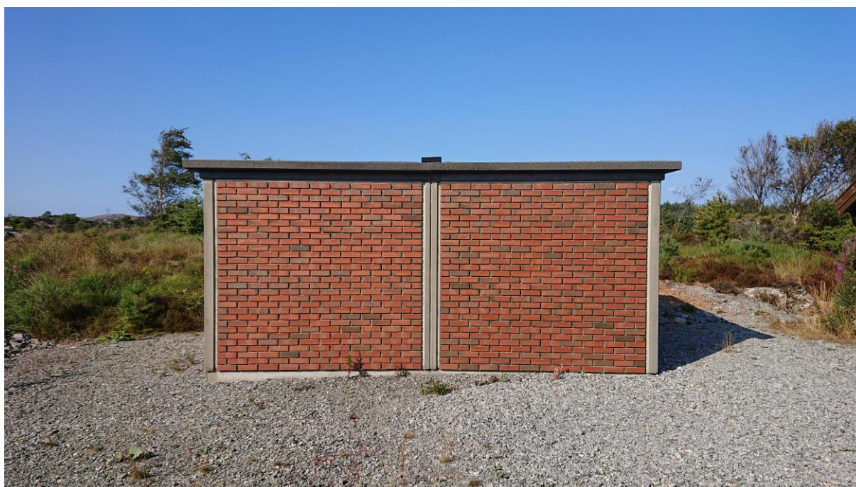
Bilde 1: Eksisterende nettstasjon i Haugaland Næringspark; et av to tilknytningspunkt (TP).
