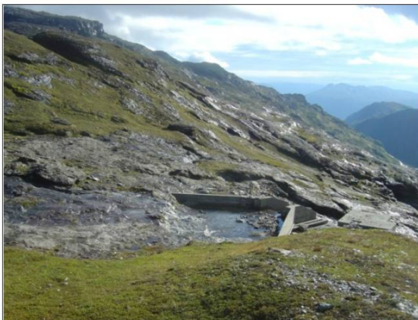
Eit eksisterande inntak på overføringstunnelen. Dette tar inn nabofeltet Tverrelva.
