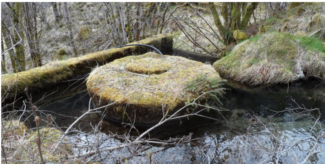
Figur 1-5 Inntakskum og terskel i Vetleelva.
