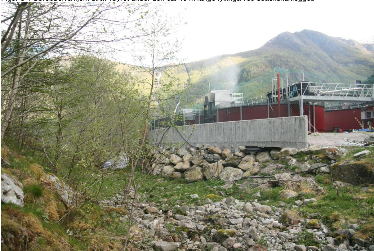
Figur 3-5 Ca. 40 m lang fylling over Sørebøelva ved settefiskanlegget.
