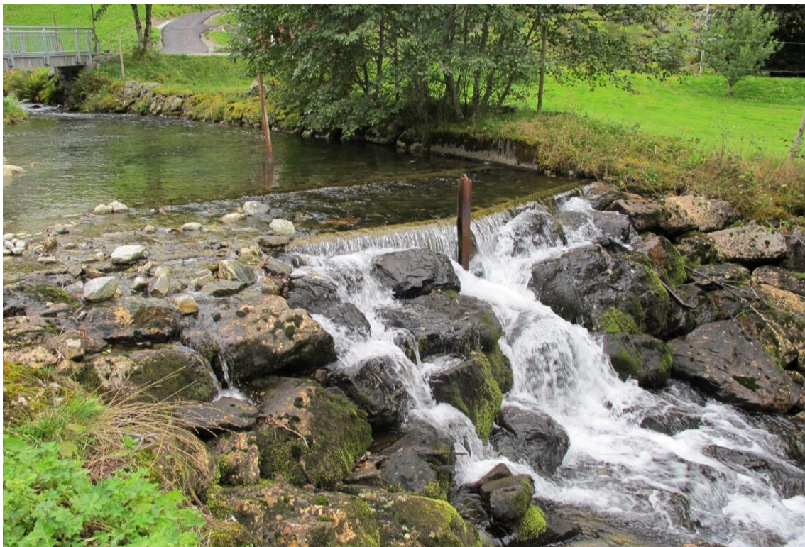
Figur 1-3 Betongterskel ved hovudinntaket i Sørebbøelva.
