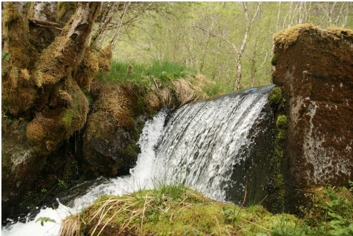
Figur 1-6 Overløp på terskelen i Vetleelva.
