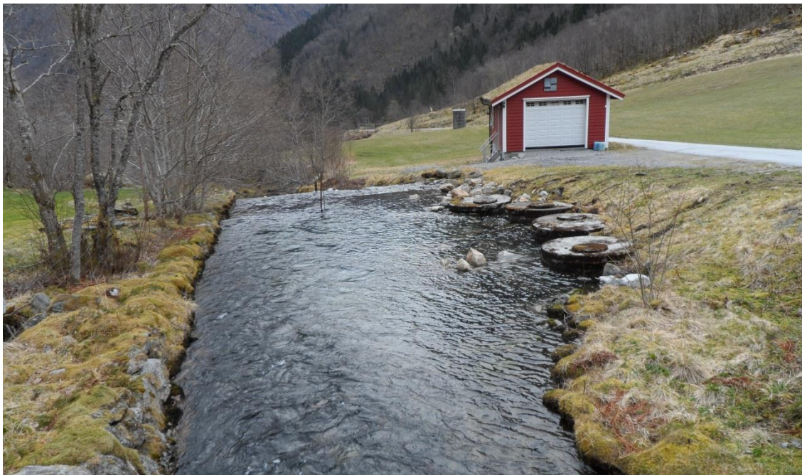
Figur 1-4 Inntakskulp i Sørebøelva sett frå oppstraums side. Betongkummane vatnet går inn i og filterstasjonen til høgre i bilete.
