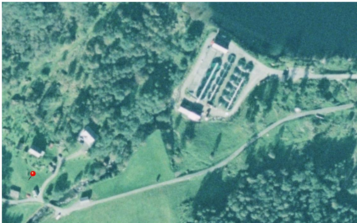
Figur 3-13 Ortofoto frå Statens kartverk. Indre Sogn 2006. www.norgebilder.no . Område for det nye bygget er mellom dei to vegane i høgre bildekant.
