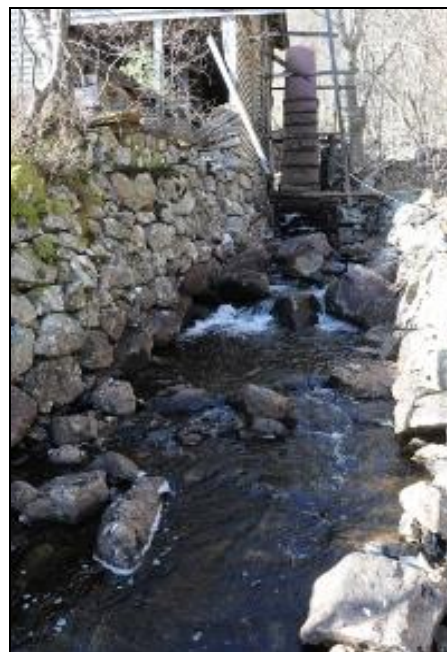
Figur 4. De to kalkbrønnene fra 1984 nedenfor inntaket i Nedre Petarteigsvatnet ble opprinnelig benyttet til kalking av vassdraget da anlegget hadde merder nederst i Petarteigspøyla. Det renner i dag ca 20 l/s fra hver av dem til vassdraget. Den nedre og lengste tilførselsledningen krysser under veibroen, mens den øvre går vestover til høyre i bildet.
