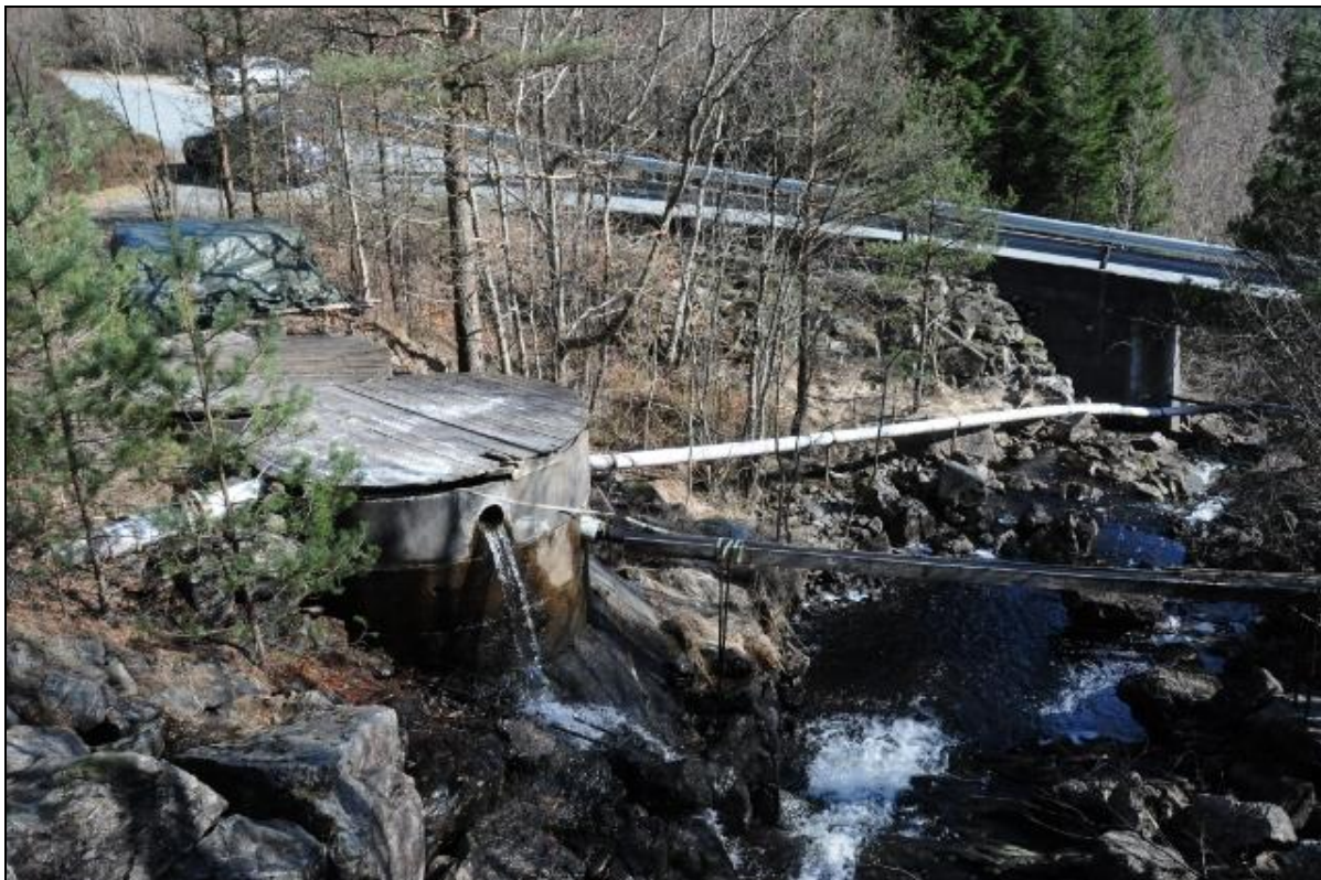
Figur 4. De to kalkbrønnene fra 1984 nedenfor inntaket i Nedre Petarteigsvatnet ble opprinnelig benyttet til kalking av vassdraget da anlegget hadde merder nederst i Petarteigspøyla. Det renner i dag ca 20 l/s fra hver av dem til vassdraget. Den nedre og lengste tilførselsledningen krysser under veibroen, mens den øvre går vestover til høyre i bildet.
