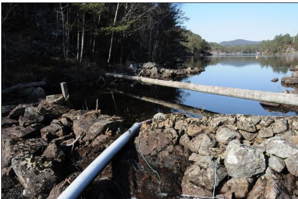
Figur 3. De gamle og utette steindammene i Øvre og Nedre Petarteigsvatna.
