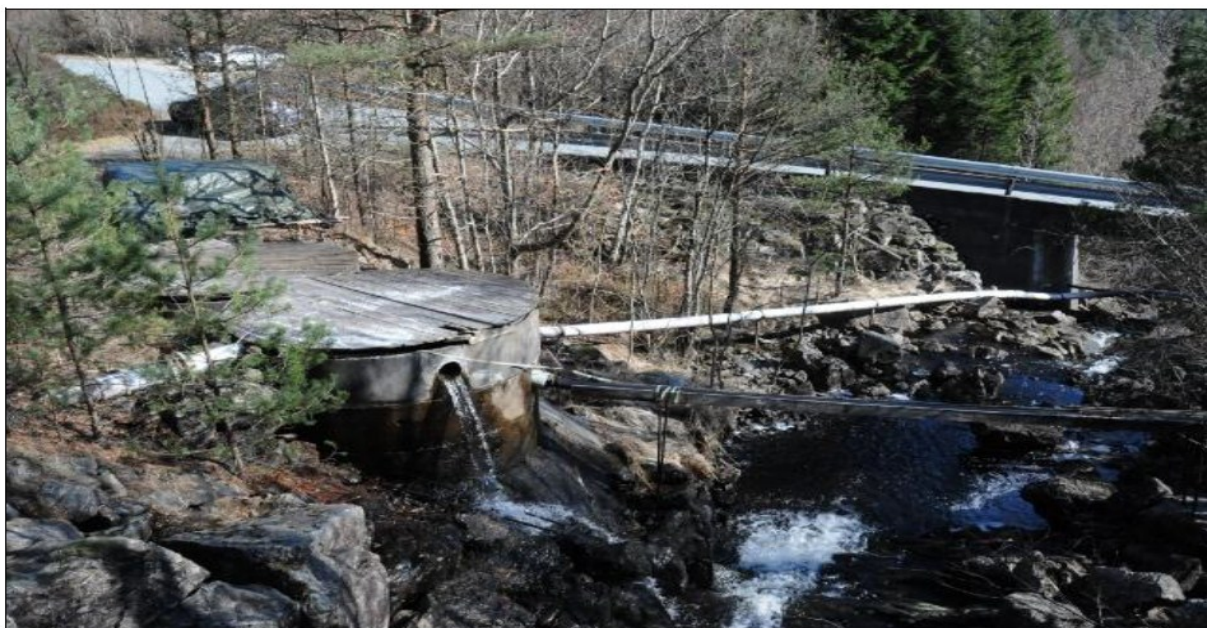
Figur 5 Dei to kalkbrønnane frå 1984 nedanfor inntaket i Nedre Petarteigsvatnet blei opprinneleg nytta til kalking av vassdraget då anlegget hadde merdar nedst i Petarteigpøyla. Det renn i dag ca 20 l/s frå kvar av dei i vassdraget. Den nedre og lengste tilførselsleidninga kryssar under vegbrua, medan den øvre går vestover til høgre i biletet.
