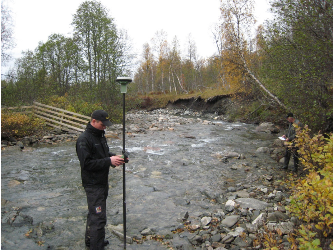
Bilde 21 Erosjonsområde sett nedstrøms fra kraftstasjonsområdet, (Tinfos, 26.9.2012).
