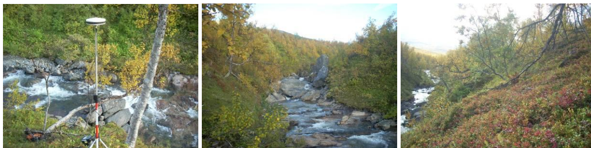
Bildene over viser sted for planlagt inntaksdam (venstre), inntaksbasseng (midten) og utgang rør (høyre).
