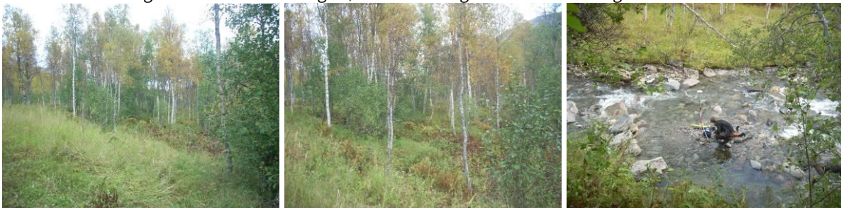
Bildene over viser nedre del av rørgata ned til stasjonstomt, med utløp på bildet til høyre.
