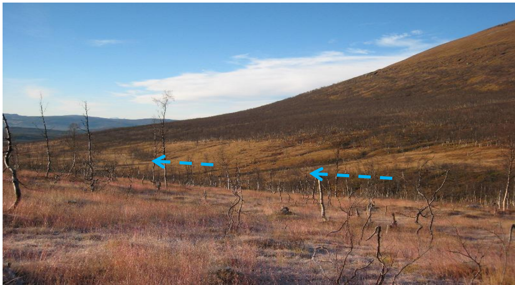
Bilde 8 Skarelva går skjult i bunnen av dalen. Utsyn mot nordvest. Striplede piler antyder øvre deler av rørtraseen. Flere bekker renner inn i Skarelva nedenfor inntaket (som ligger utenfor høyre bildekant). (Tinfos, 17.10.2012).
