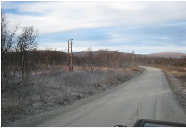
Bilde 6 Forsvarets vei fra Akkasæter i utkanten av Skardalen. På venstre siden av veien (vestsiden) ligger 22 kV luftledning og trafo hvor Skarelva kraftverk kan kobles til via luftlinje eller jordkabel (Tinfos, 17.10.2012).
