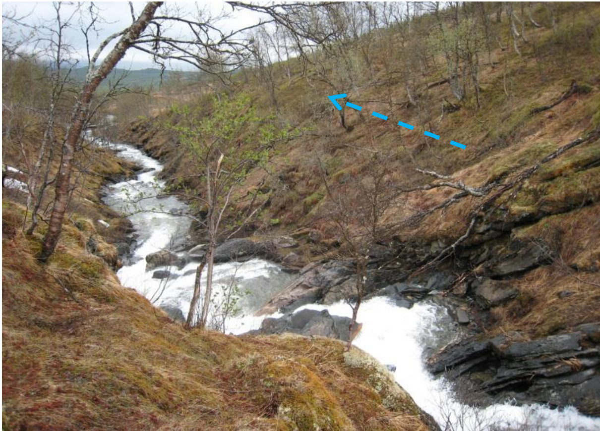
Bilde 24 Like nedstrøms damsted, samme sted som bilde 24, striplet pil antyder traséutgang. (Tinfos, 4.6.2010).
