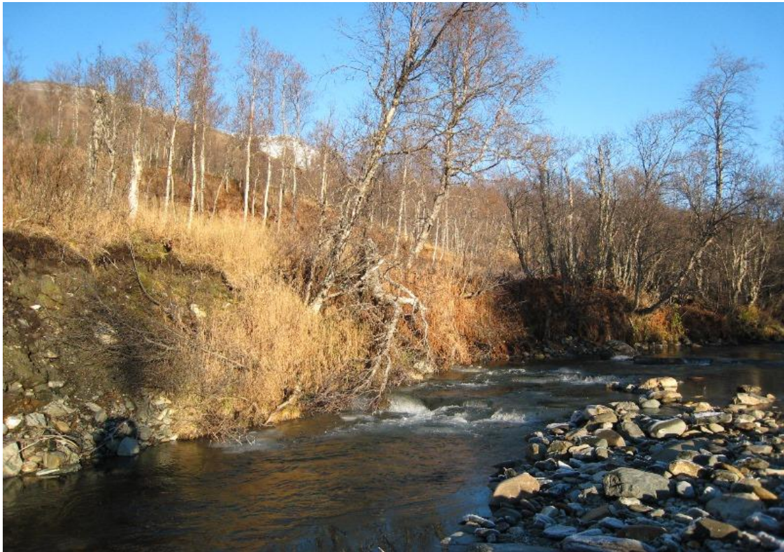
Bilde 30 Kraftverkstomten er planlagt på bakre bredd i høyre del av bildet Utløpet vil anlegges i bakkant av bildet. Erosjonsskadene som sees til venstre oppstod etter flomvannføring i forbindelse med snøras i Utrapbekken som demmet opp Skarelva midlertidig. (Tinfos, 17.10.2012).
