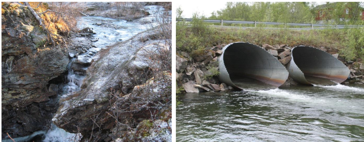
Figur 8 Vandringshinder i Øverfossen (tv), ca 10 meter høyt, og ved Storjorda (th). Øverfossen befinner seg umiddelbart etter samløpet mellom Skarelva og Mårelva. Kulverten ved Storjorda ligger i Mårelva, drøyt to km nedenfor Øverfossen. Bildet fra Øverfossen er tatt 17.10.2012 (foto: Tinfos), og bildet fra Storjorda er tatt 16.6.2010 (foto: Fylkesmannen i Troms).
