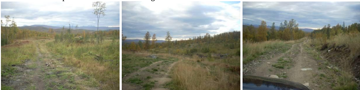
Bildene over utdrag fra nedre deler av rørgata, de traseen følger eksisterende skogsbilvei.
