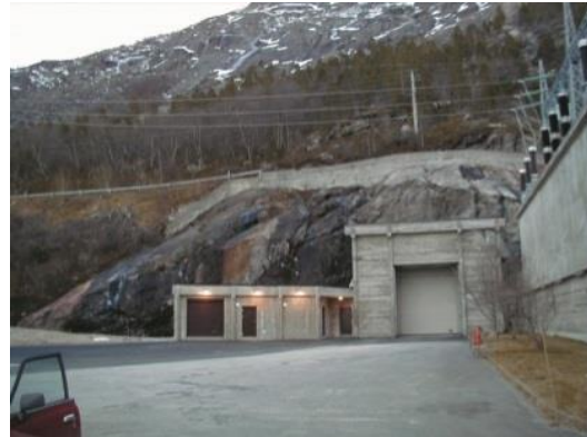
Foto: Portalbygg Skjomen kraftverk.
