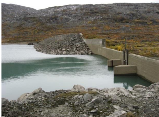
Foto: Inntak Norddalen dam (Nordelva).
