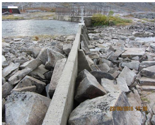
Foto: Inntak utløp Kobbvatn (Sørrelva).
