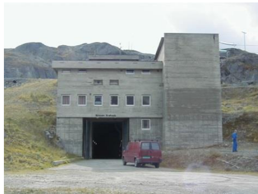
Foto: Portalbygg Båtsvatn kraftverk.
