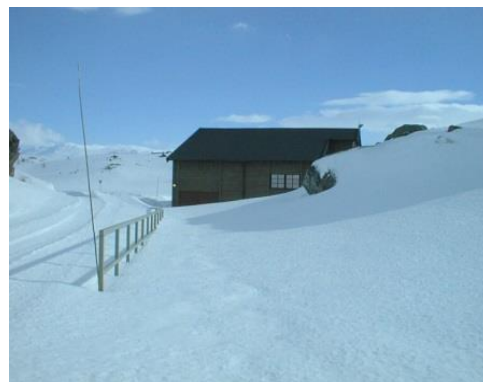
Foto: Norrdalen kraftverk.
