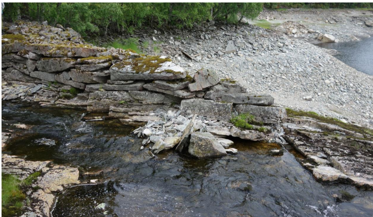
Figur 15 Biletet viser utløpet av Oselva i Nordstrandsvatnet. Som ein ser er elva forbygd her. Dette er for å hindre graving i lausmassane på austsida av elva (Foto; Solfrid Helene Lien Langmo © 19.06.2013).
