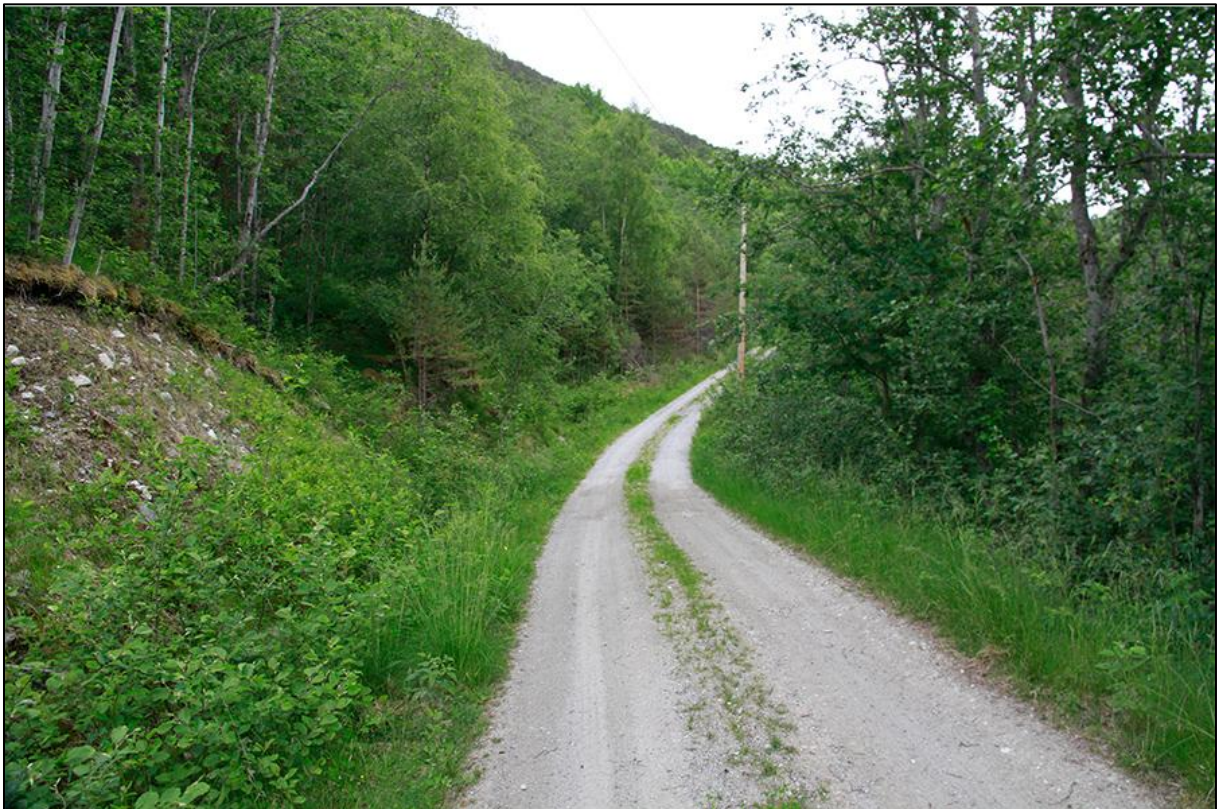
Fig. 35. I det nedre avsnittet av rørtraséen vokser tett løvskog innpå bygdeveien der rørtraséen må legges på oppsiden/innsiden ettersom terrenget på nedsiden er bratt ned mot Kinsedalselv. 17. juni 2014. Foto: A. Håland©
