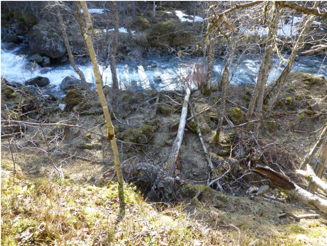
Figur 2. Øvre del av rørtrase
