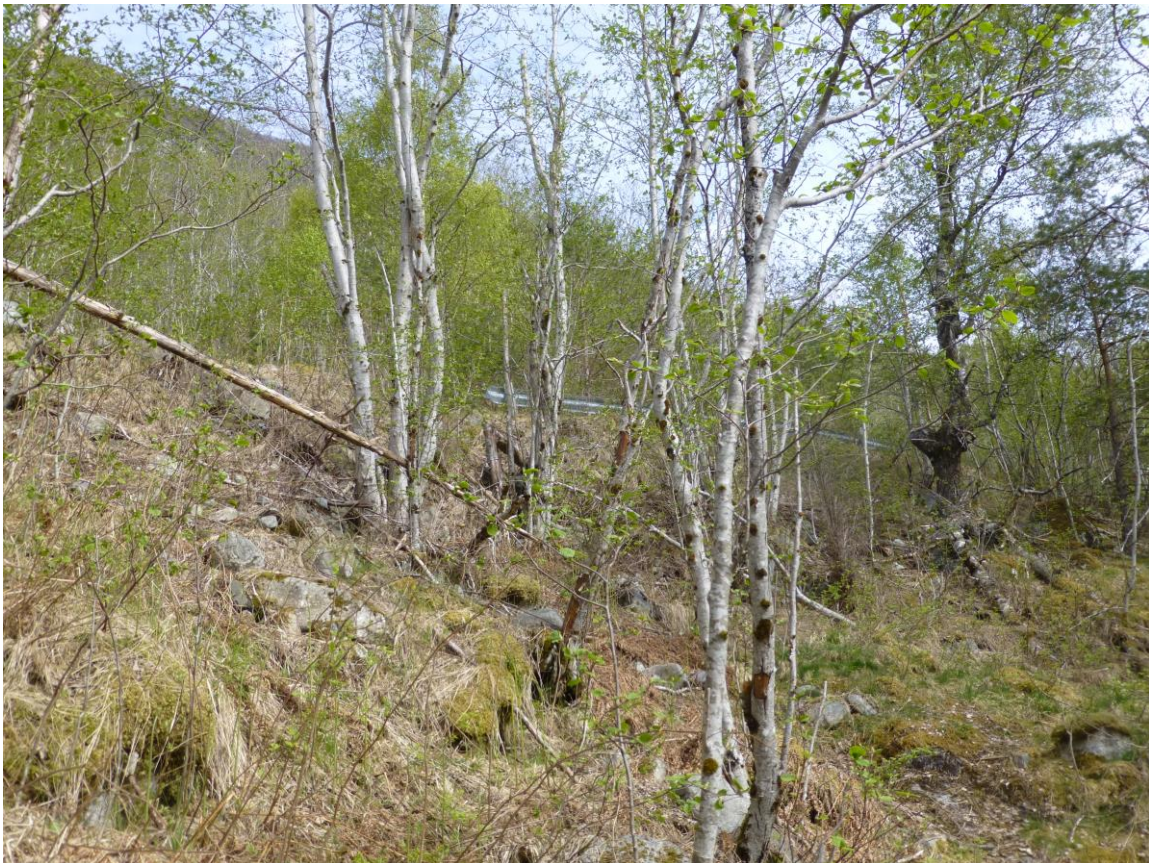
Figur 6. Nedre del av rørtrase.
