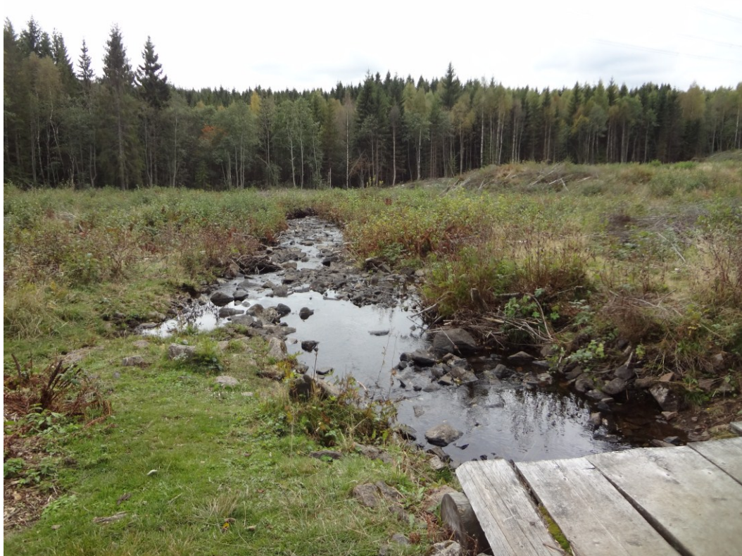
Figur 1-6: Gjennom tiltaksområde. Omtrent samme standpunkt som forrige bilde (28.9.2013)
