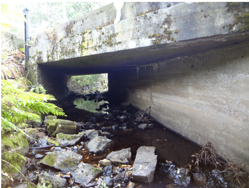
Figur 1-8: Kulvert under Vestmarkveien (14.9.2013)
