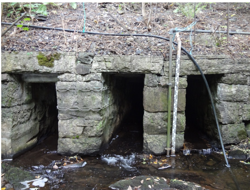
Figur 1-12: Bekkelukking for jernbane og vei, rett nedstrøms Åstaddammen (14.9.2013)
