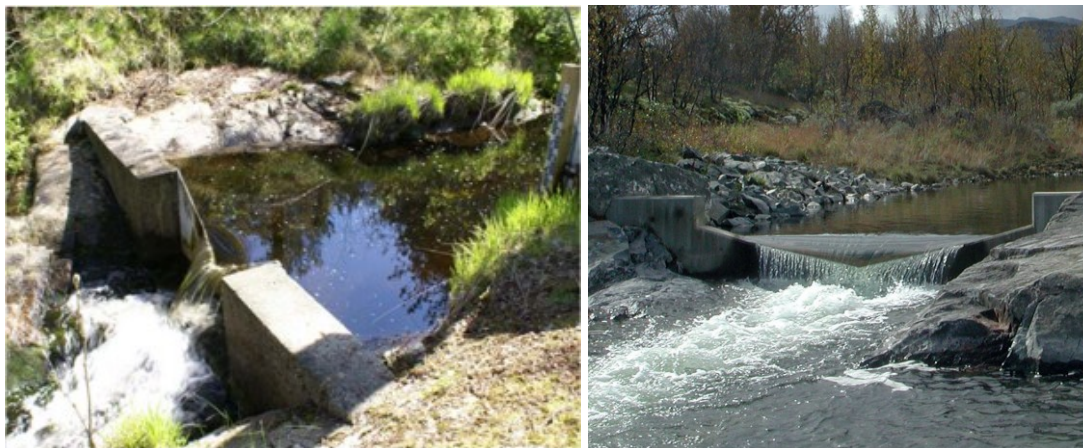
Figur 5: V-formete overløp (bilder tatt fra NVE-veileder 1/2012)
