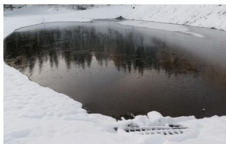
Figur 8: Overløp i damvoll (bilde tatt fra Sætertjern, Holmenkollen og figur fra www.basal.no )
