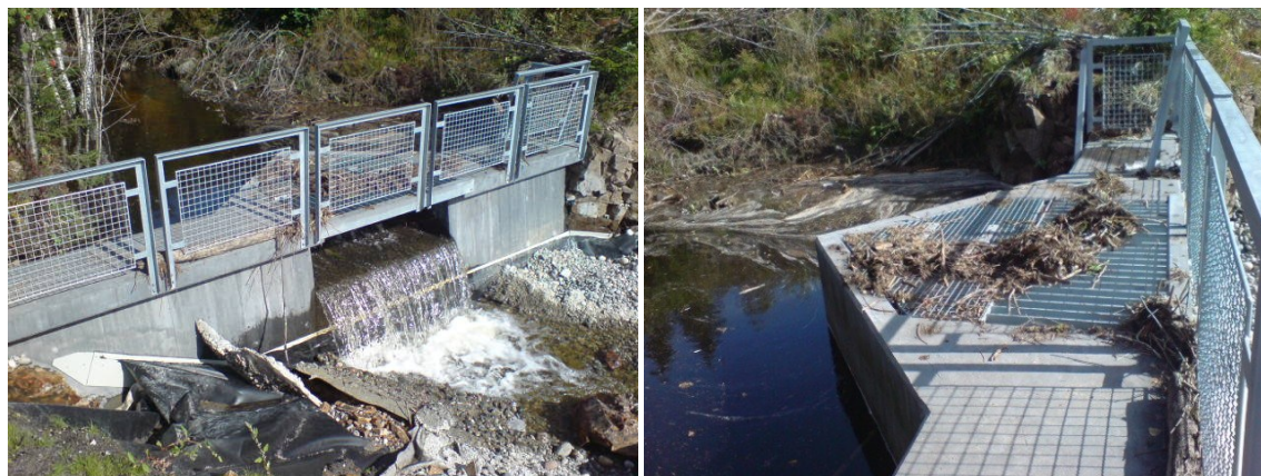
Figur 3: Det er viktig med vedlikehold i form av rensing av rister for å hindre oversvømmelser (bilde tatt fra oppstrøms Midtstudammen, Holmenkollen)
