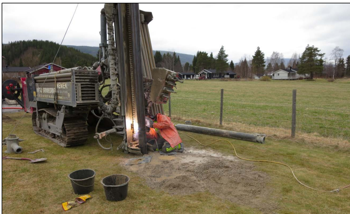
Figur 3. Sveising av fôringsrør ved undersøkelsesboring-1 (Ub-1) ved Rendalen sykehjem.
