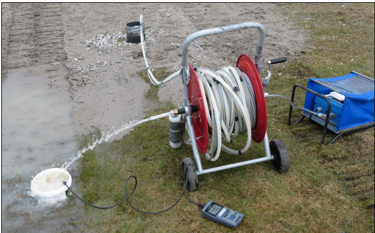
Figur 5. Pumping med uttak av vannprøver og måling av grunnvannets temperatur og ledningsevne.
