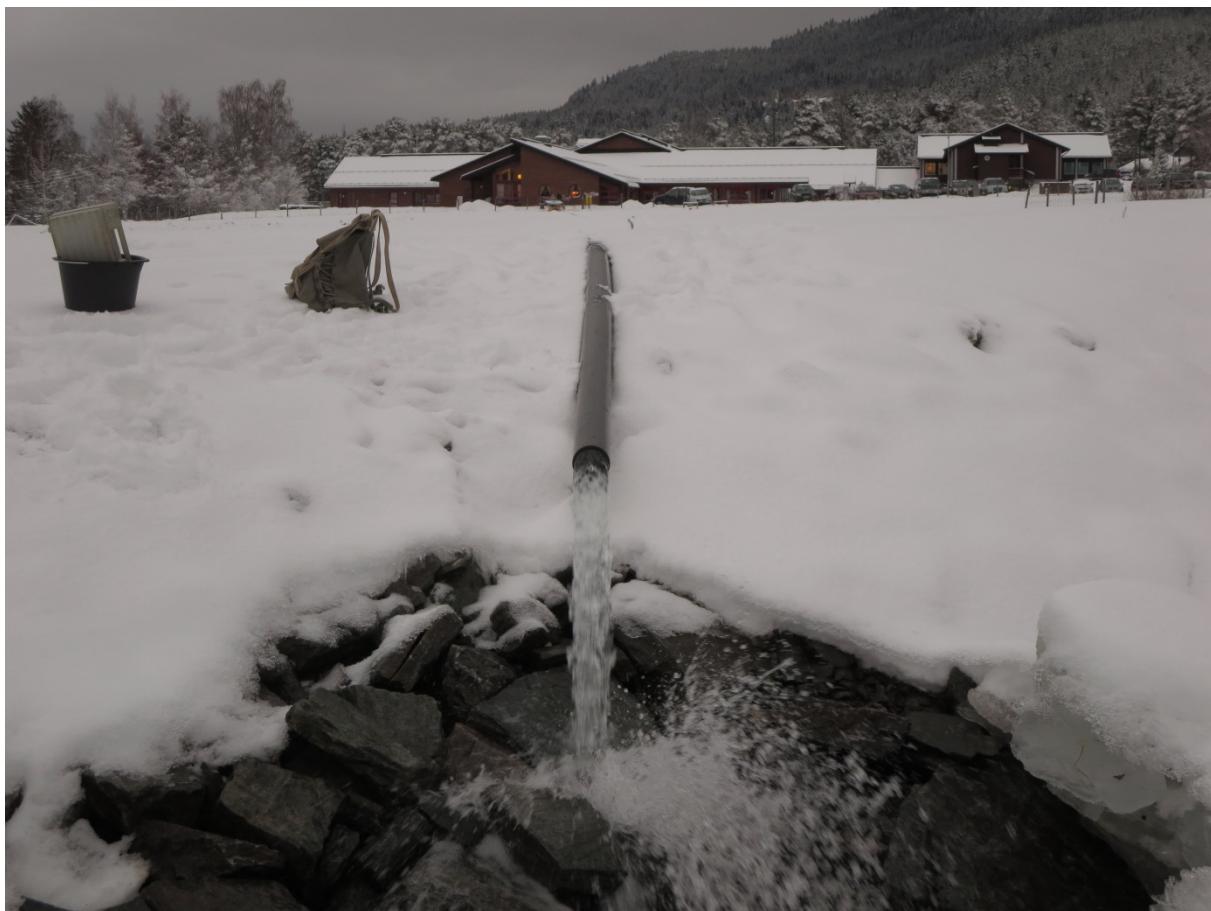
Figur 9. Grunnvannet pumpes til elva (Rendalen sykehjem i bakgrunnen).
