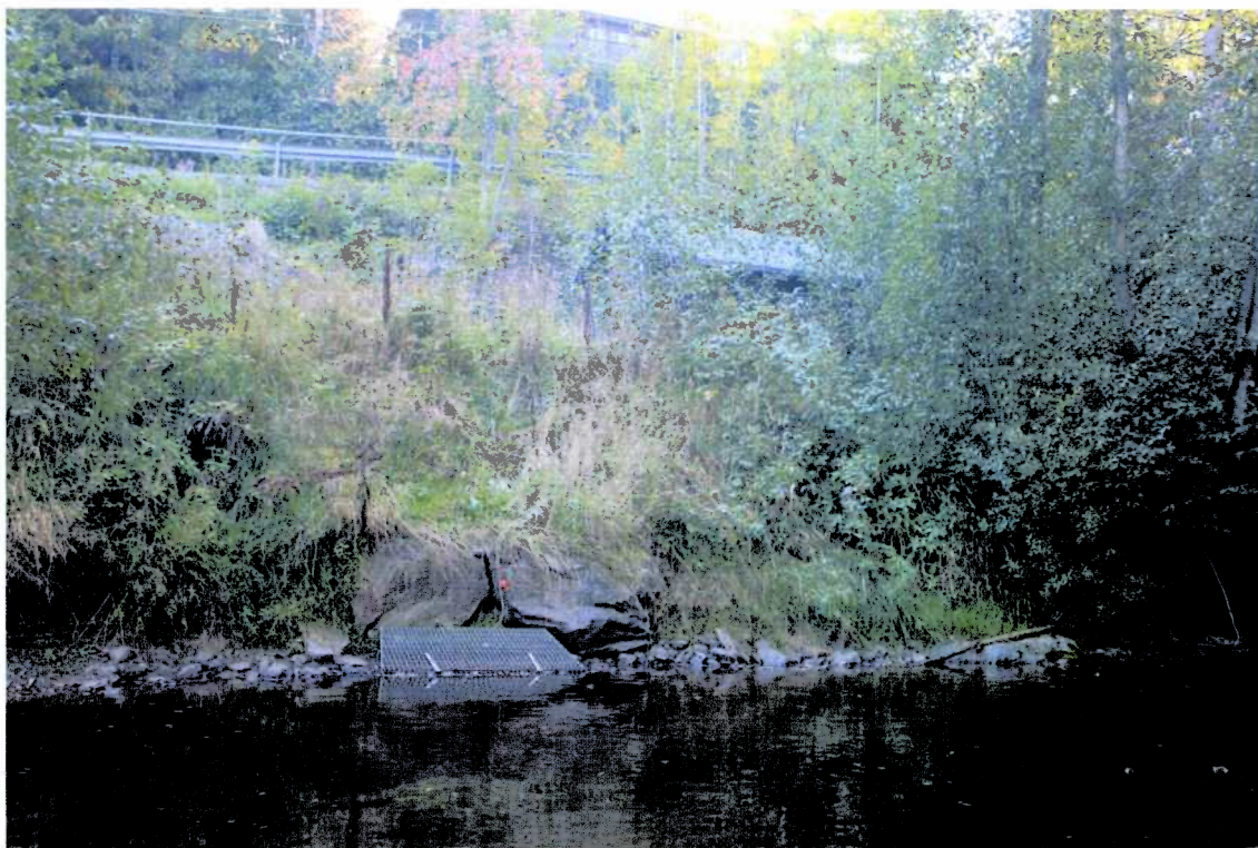
Bilde: Inntakskum plassert ved elvebredden oppstrøms kulp. Pumpehuset i ca 15m avstand til elven med god vegetasjon i grøntbeltet mellom elven og pumpehuset.
