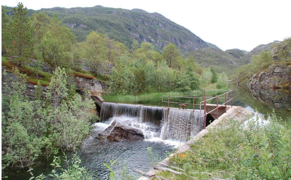
Figur.14. Overløpsdam demning 1 i Lillevatn
