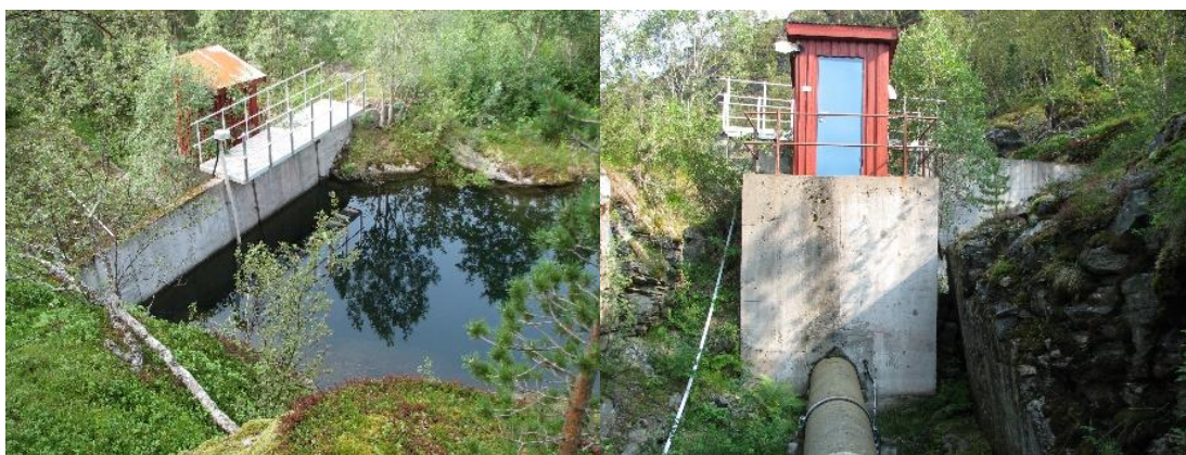
Figur 15. Oversikt demning 2 i elv nedenfor Lillevatn med damhus, og uttak turbinrør fra dam.
