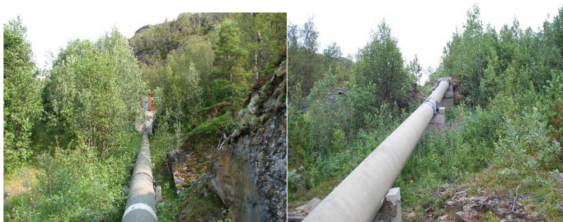
Figur 17. Turbinrør i terrenget
