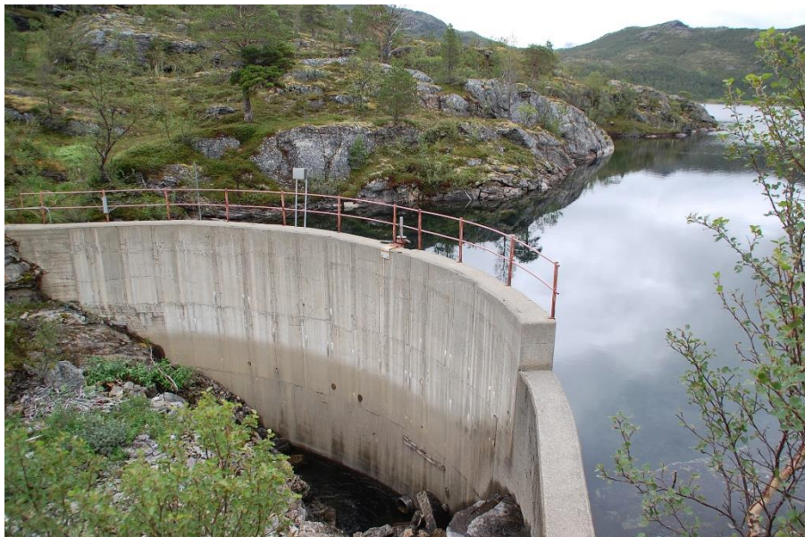
Figur 10. Demning ved Storvatn
