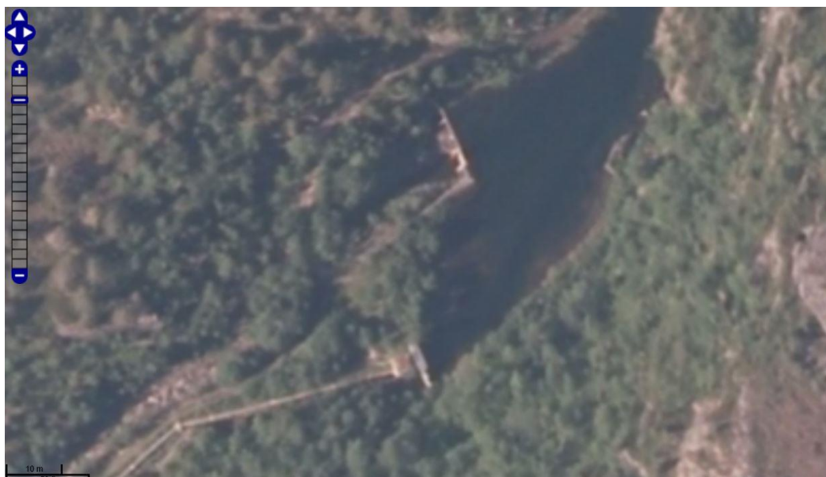
Figur 13. Inntaksdam og overløpdam ved Lillevatn
