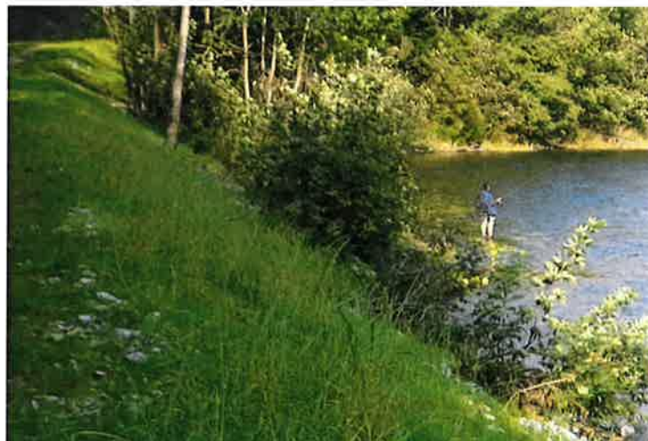
Fig. 28 Laksefiske ved ny anleggsveg/tursti. Foto: Kon-Sul AS 16. september 2016
