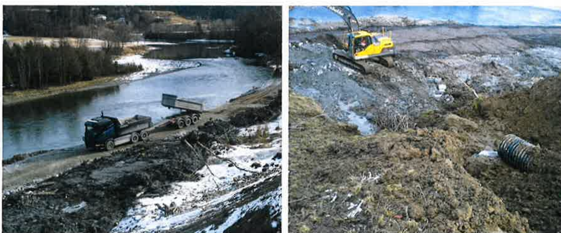
Fig. 20 Transport gjennom skredområdet (t.v.) . Arbeid med forlenging av overvassleidning ned til elvenivå (t.h.). Foto: Kon-Sul AS 31. mars / 10. mars 2016
