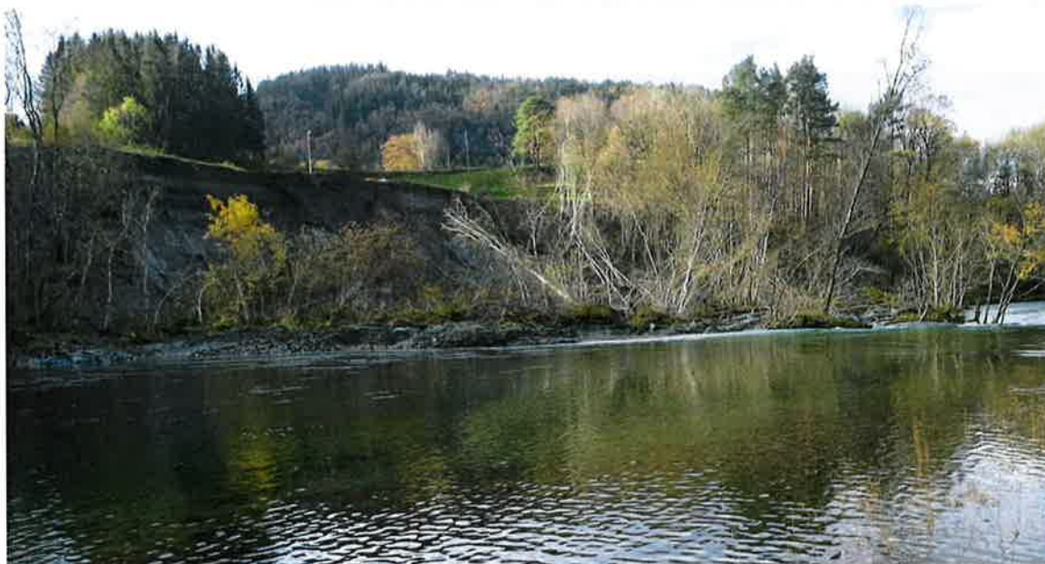
Fig. 4 Skredområdet 17.10.14, sett frå motsett elvebreidd (Foto: Kon-Sul AS)
