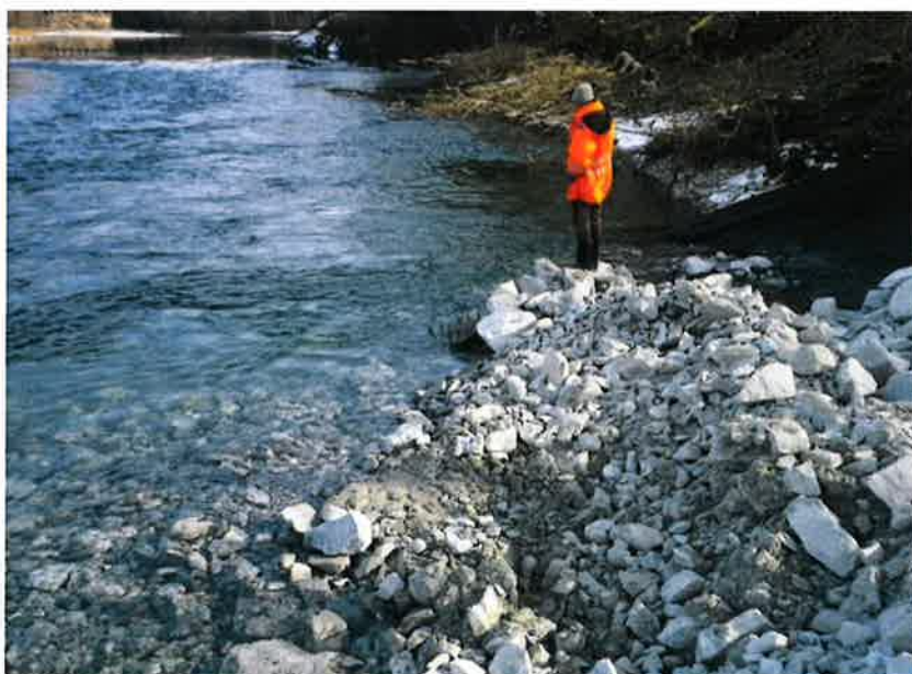
Fig. 24 Lokal utgliding av vegfylling. Foto: Kon-Sul AS 11. mars 2016
