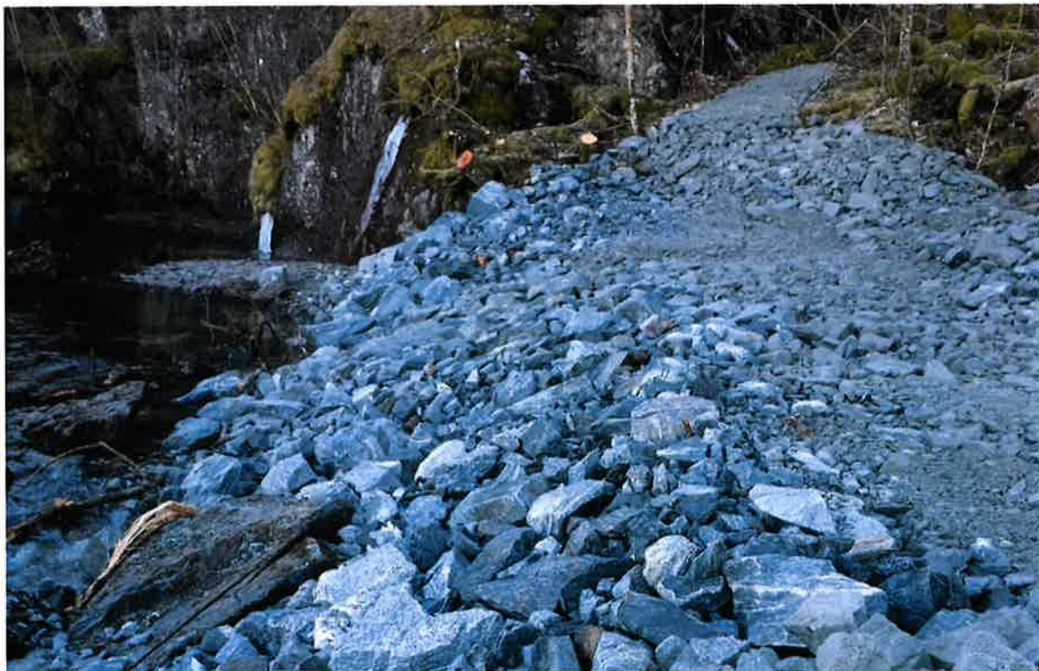
Fig. 22 Avslutning av erosjonssikring mot fjellterskel oppstrøms skredområdet. Foto: Kon-Sul AS 16. mars 2016
