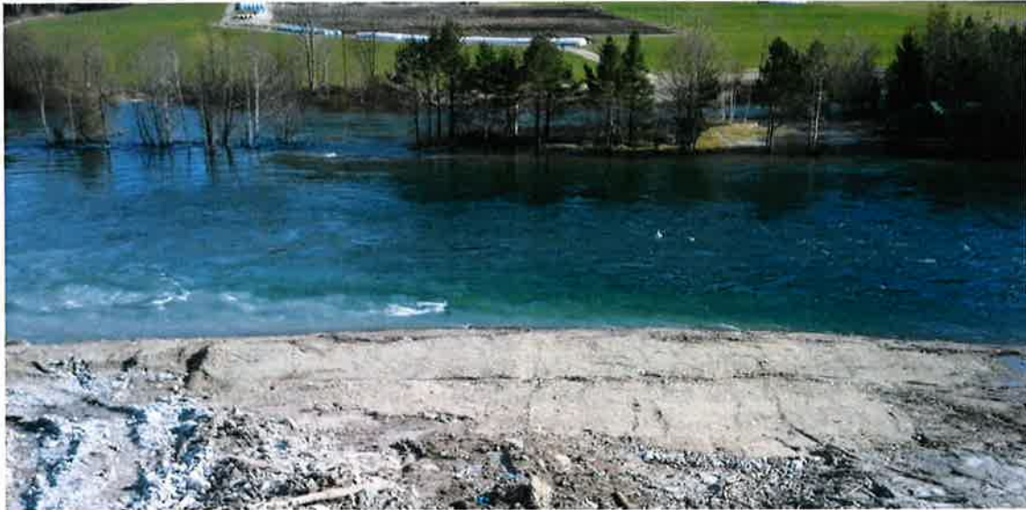
Fig. 25 Utvasking av skredmasser utanfor fylling, spyleflaum 28. april 2016 (Foto Kon-Sul AS)
