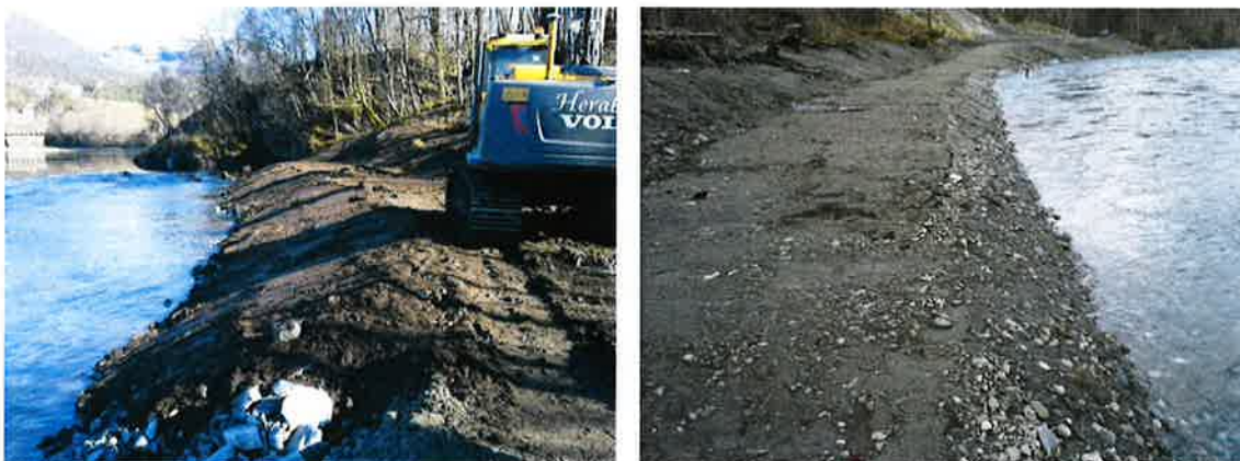
Fig. 23 Utlekking av topplag av naturgrus og matjord (t.v.) og etter spyleflaum (t.h.). Foto: Kon-Sul AS 17. mars / 1. mai 2016
