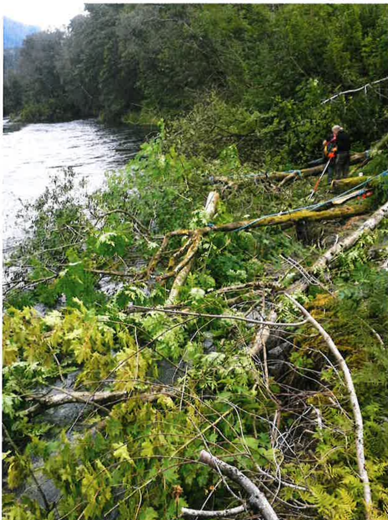
Fig. 12 Mannskap frå Suldal kommune gjennomfører tiltak for å redusere erosjon ved å felle tre som reduserer straumhastigheten langs elvekanten. Foto: Kon-Sul AS 10. august 2015
