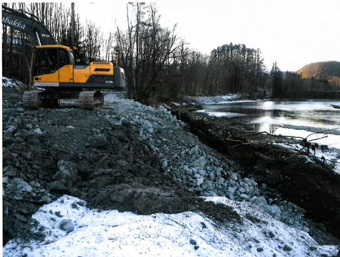
Fig. 17 Masseutskifting gjennom skredmassar. Foto: Kon-Sul AS 7. mars 2016
