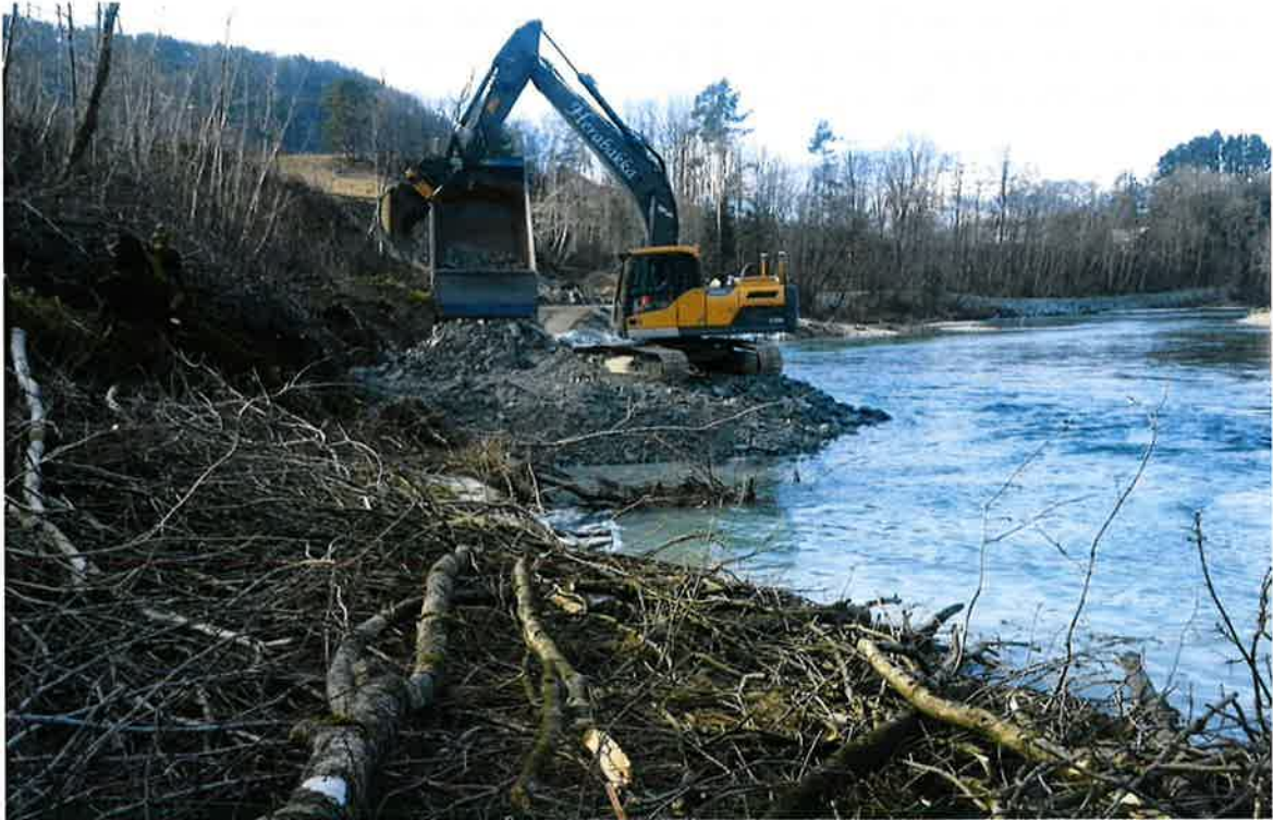
Fig. 21 Arbeid med vegfylling overfor skredområdet. Foto: Kon-Sul AS 14. mars 2016
