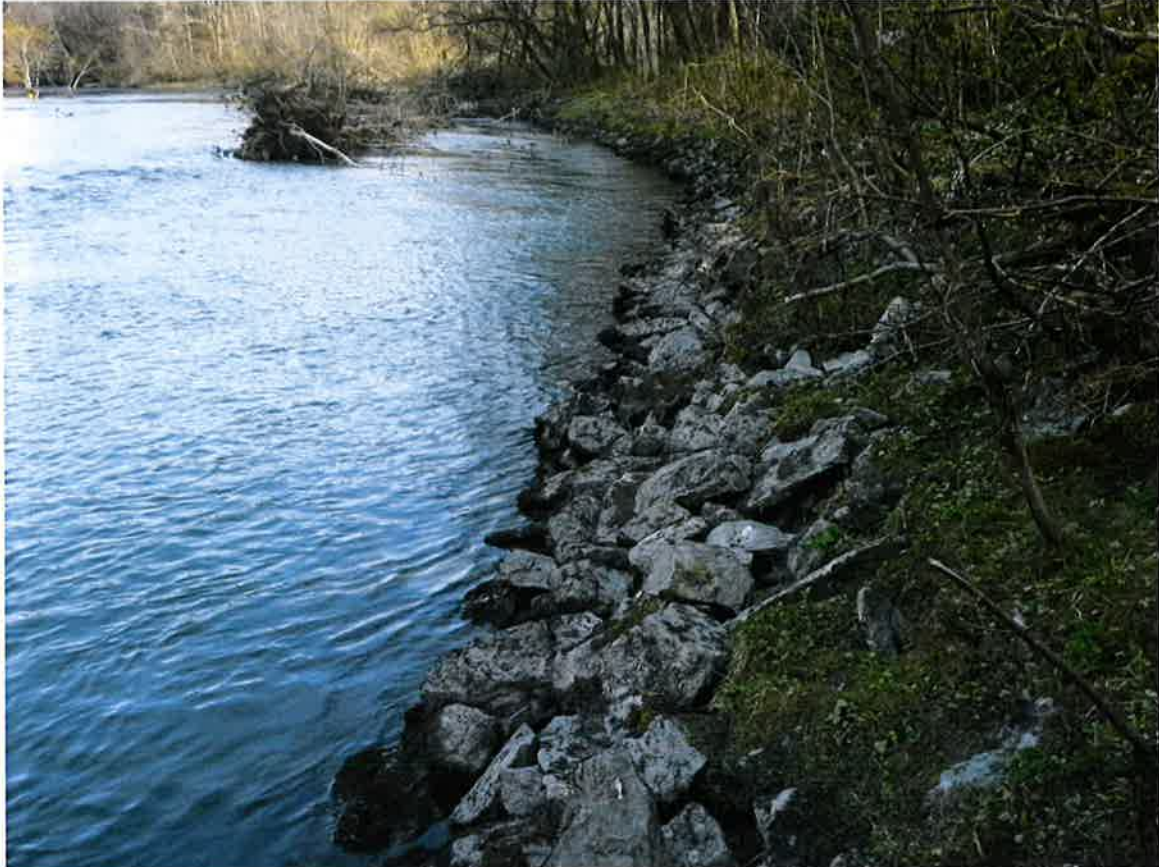
Fig. 7 Erosjonssikring frå 1904 langs elvekanten nedanfor skredområdet. Foto: Kon-Sul AS 3. mai 2015
