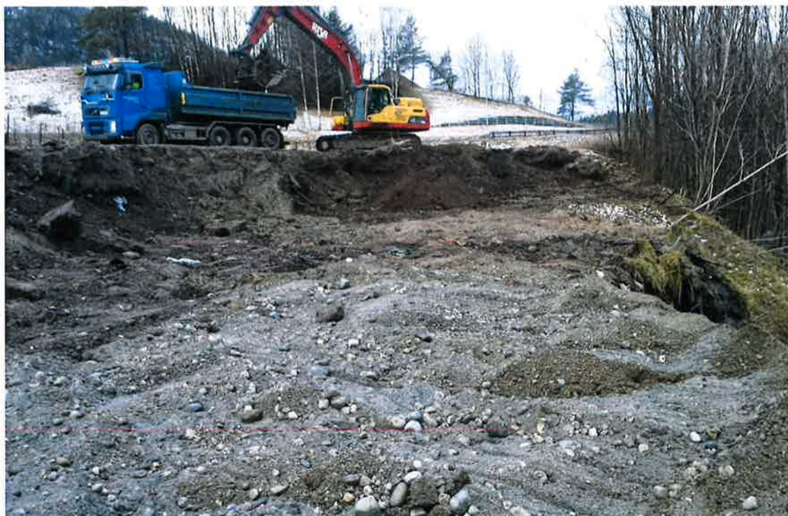
Fig. 13 Ein del av naturgrusen frå avlastingsområdet blei nytta til oppfylling av botsenking. Foto: Kon-Sul AS 23. februar 2016
