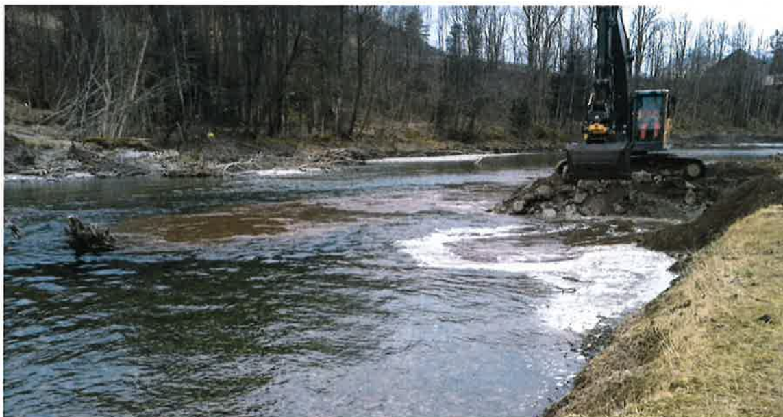
Fig. 19 Oppfylling av botnsenkning. Foto: Kon-Sul AS 18. februar 2016
