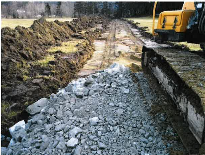
Fig. 15 Mellombels adkomstveg over dyrka mark, avtaking av matjord til ranke og utlegging av samfengt sprengstein. Adkomstvegen er fjerna etter at sikringsarbeida er utført. Foto: Kon-Sul AS 11. februar 2016
