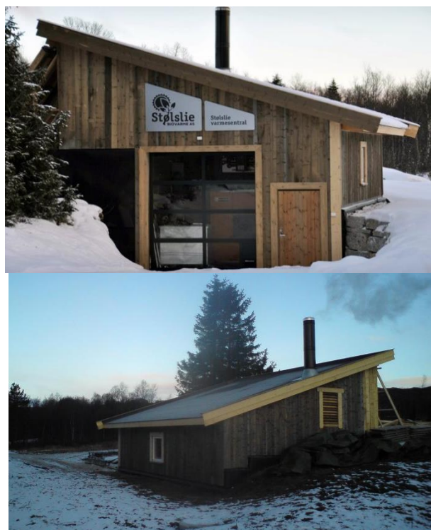
Figur 1 Stølsie varmesentral, eksisterende anlegg
