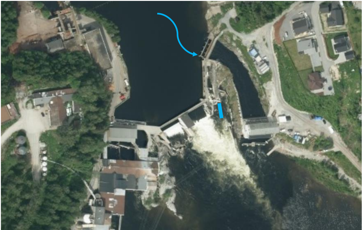
Figur 1: Satellittbilde av Hellefoss kraftverk i Drammenselva. Den blå pila viser en av de antatt viktigste nedvandringsrutene for laks og sjøørret i perioder med lite vannføring over lukene, og det blå feltet i østre inntakskanal angir hvor det ble observert vinterstøinger av laks under befaringen den 2. mai 2016. Det observeres opptil flere hundre laks i dette området hver vår. Laks og sjøørret samles også i noen grad på vestsiden.
