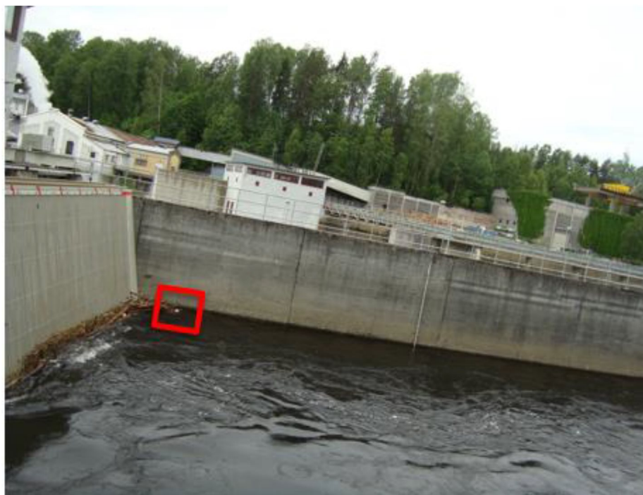
Figur 5: Planlagt plassering av luke i dam. Plasseres på oppstrøms side. Overflatestrømning gjennom luka.
