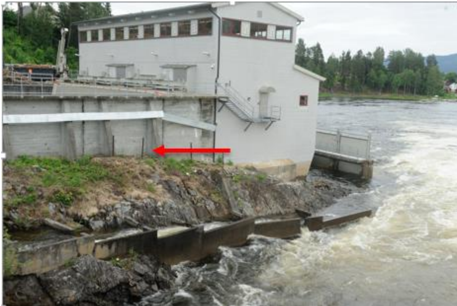
Figur 6: Pilen peker på planlagt åpning i dam-mur. Eksisterende fisketrapp og eiendomsgrensestolper sees også på bildet.
