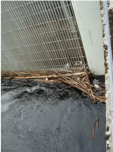
Figur 3: Drivgoods på varegrind (like ved planlagt lukeplassering).
