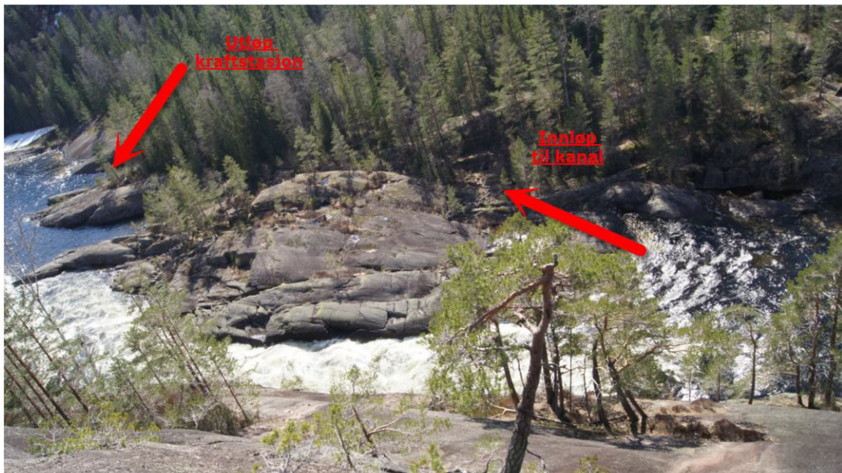
Fig 17. Bilde av stryket tatt fra Stågekollen. Innløp til kanal og utløp fra kraftstasjon indikert med piler.
